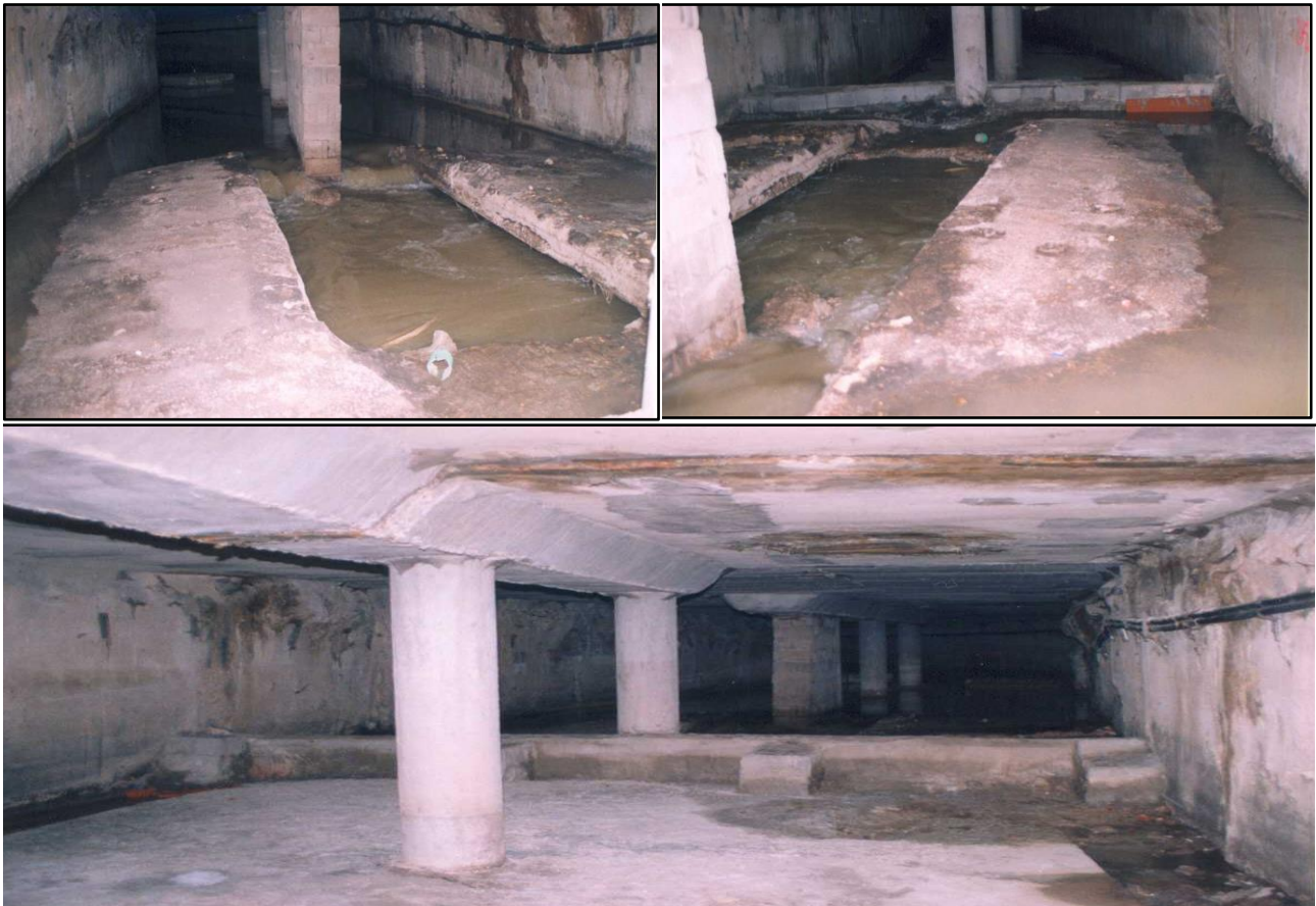
Figura 6 – Imágenes del segundo foso de negras (Arriba izquierda, vista hacia aguas arriba. Arriba derecha, vista hacia aguas abajo) y del murete (Vista hacia aguas arriba.) [3]
