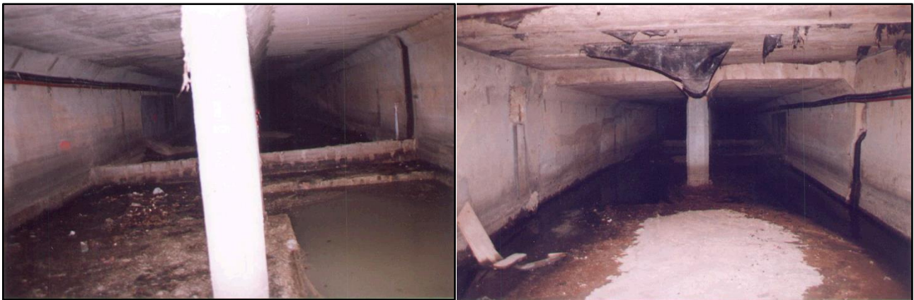
Figura 4 – Imágenes de la derivación de negras mediante foso y murete existente sobre banqueta. (Izquierda, vista hacia aguas abajo. Derecha, vista hacia aguas arriba) [1]
