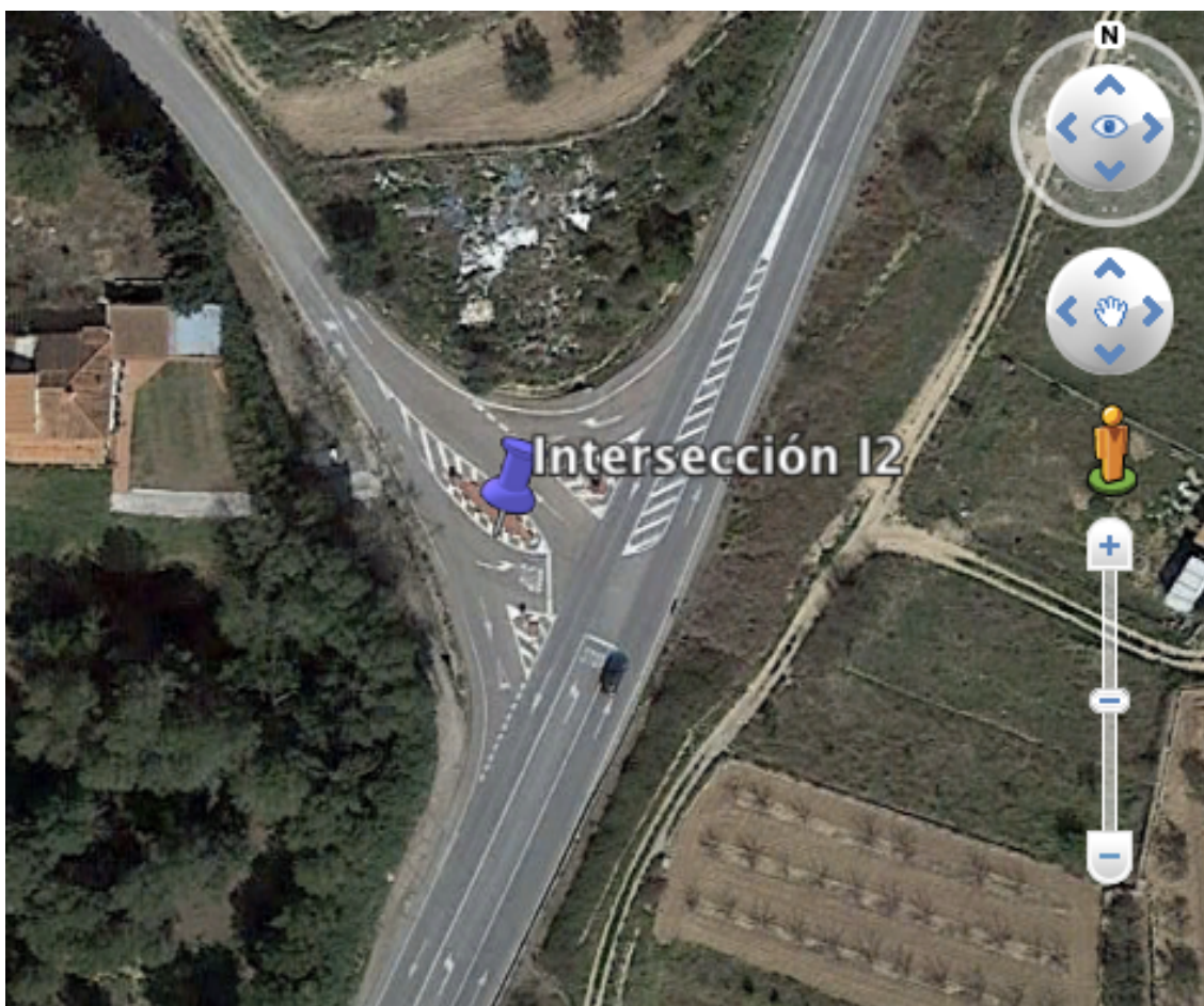
Ilustración 26 Vista aérea I2
