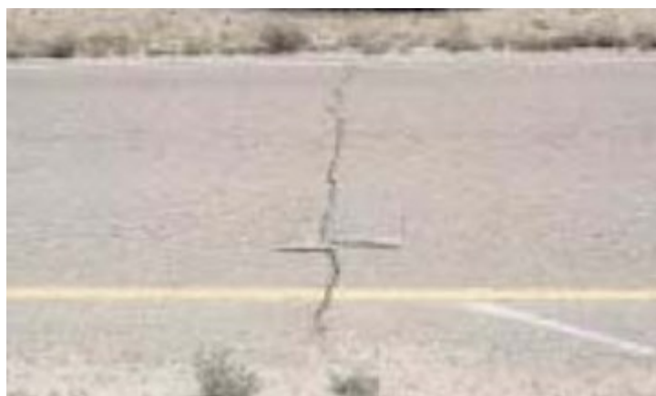
Figura 7. Fisuración transversal.
