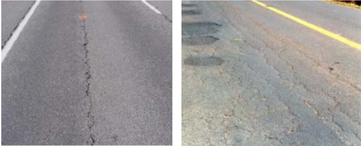
Figura 6. Fisuración longitudinal.
