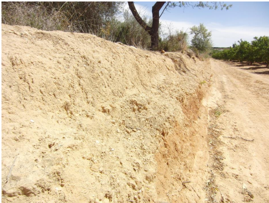
Fig. 4. Detalle de los restos de un tramo del cajero de la acequia, construida con una técnica de mortero de tierra y cal encajonada.
