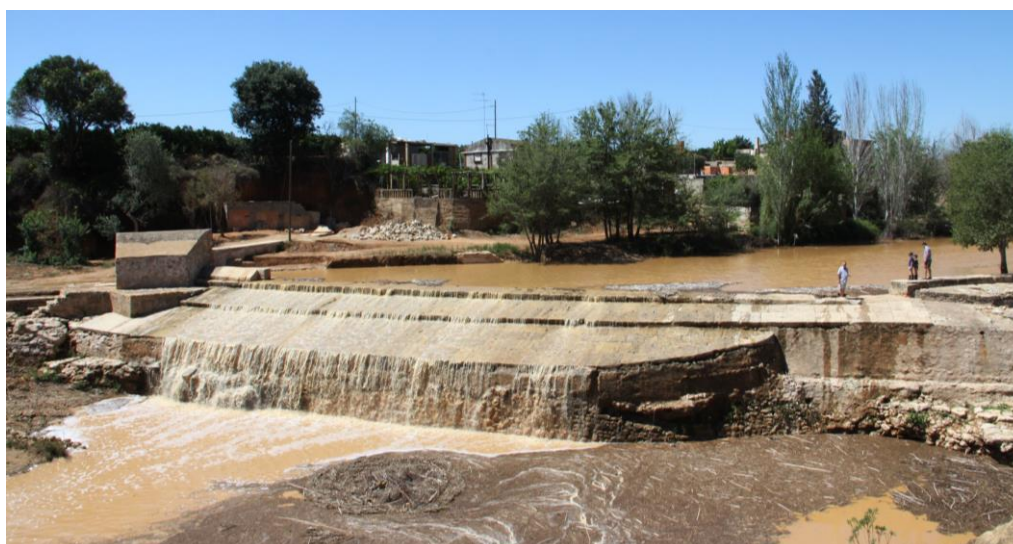
Fig. 10. Azud del Pantà de Torrent en 2014, durante una avenida tras su restauración.
