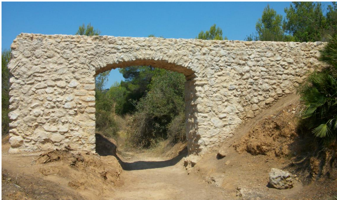
Fig. 8. Acueducto dels Arquets de Dalt, en 2011 tras su restauración.
