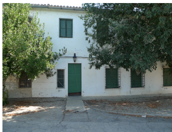
Figuras 102. Fachada Oeste. Bloque 2
