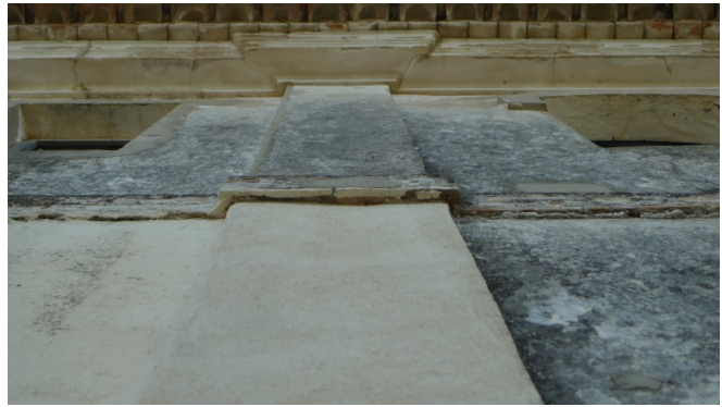
Figura 48. Pilastra Bloque 3 y moldura.
