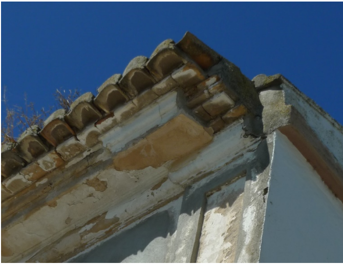
Figuras 55 y 56. Detalle de interior de la cornisa y perfil de la misma.
