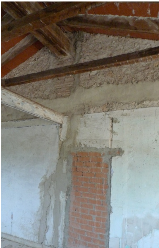
Figura 29. Vista interior de muro piñón.
