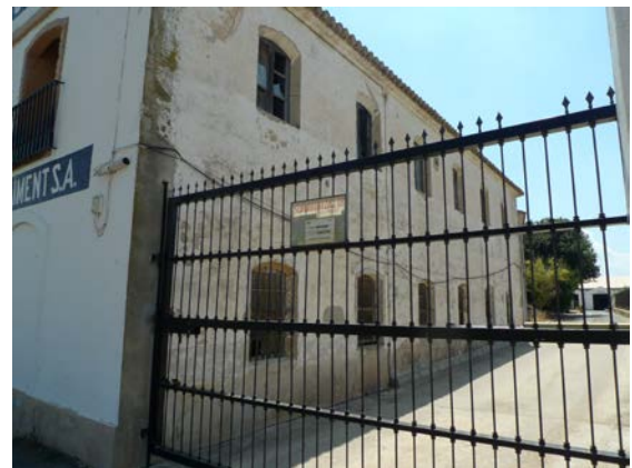
Figura 12. Bloque 1. Fachada trasera
