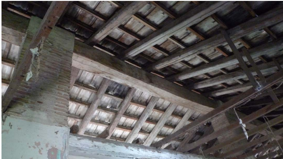
Figura 57. Vista general bajo cubierta Bloque 3
