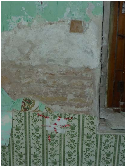
Figuras 26 y 27. Detalle de machón de ladrillo formando jambas de ventana.
