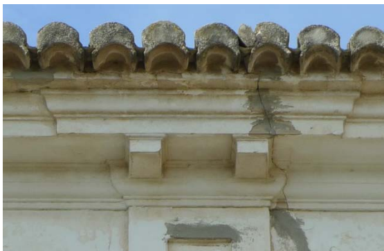
Figura 61. Detalle bocateja doble
