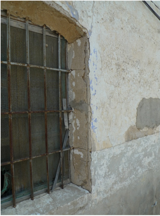
Figuras 96 y 97. Vistas de anclaje de rejillas al muro
