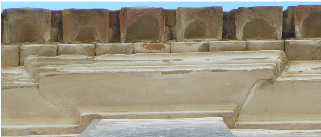
Figura 54. Detalle de cornisa fachada principal.
