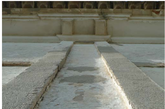
Figura 49. Pilastra Bloque 2 y moldura.
