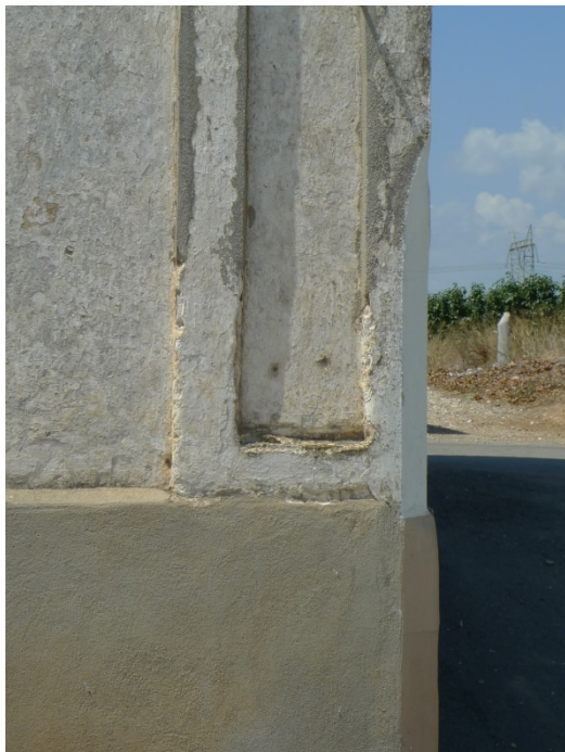
Figura 46. Base pilastra Bloques 1 y 2
