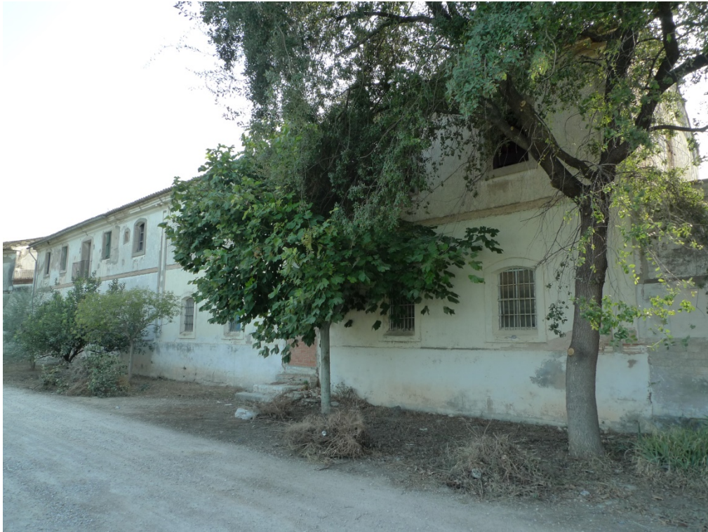
Figura 7. Vista general Bloque 2. Fachada Este.
