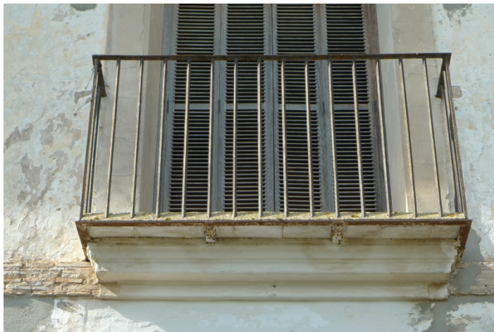
Figura 50. Vista general de balcón Bloque 2.
