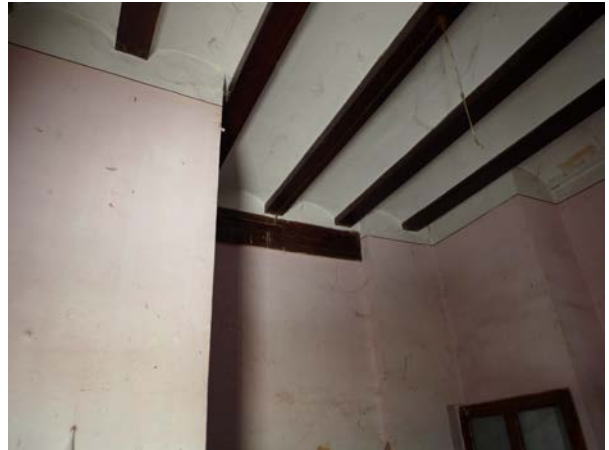
Figuras 89 y 90. Viguetas de madera de forjado de planta.
