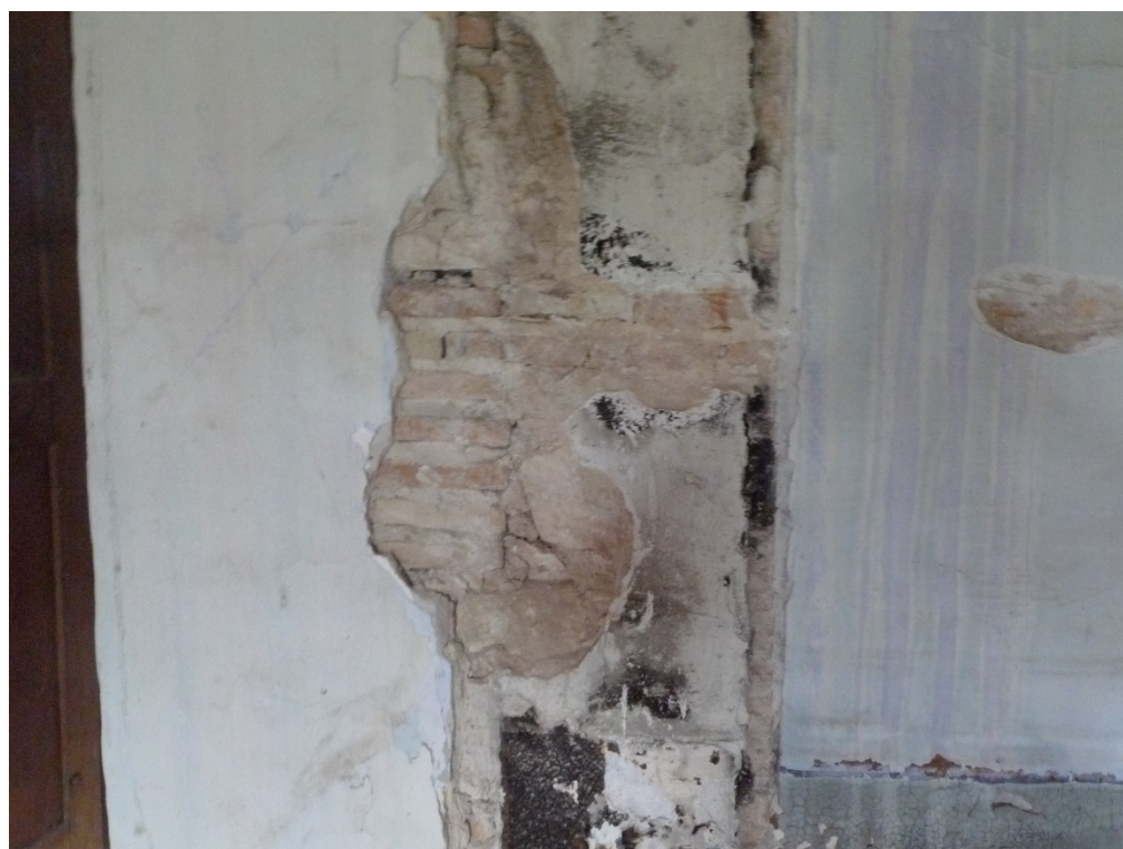
Figura 24. Machones de ladrillo en lateral de ventana y verdugada intermedia.
