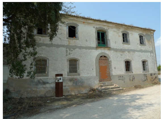
Figura 13. Bloque 1. Fachada principal
