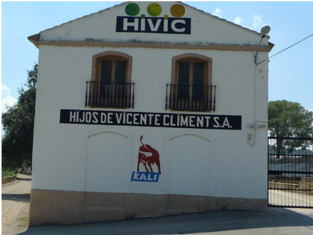
Figura 10. Diferencia de nivel entre viales Este y Oeste
