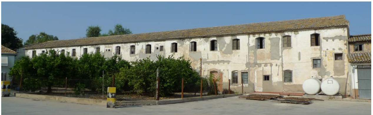
Figuras 116. Fachada Oeste Bloque 3
