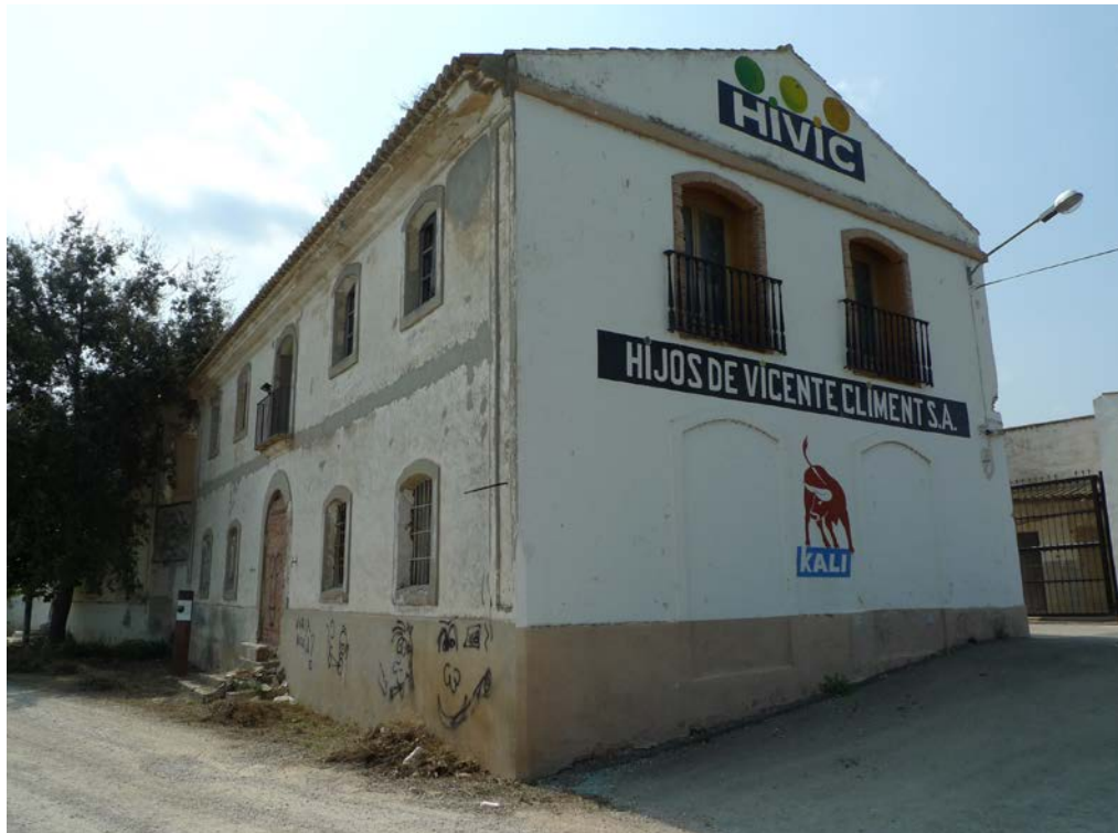
Figura 6. Vista general Bloque 1. Fachadas Norte y Este.
