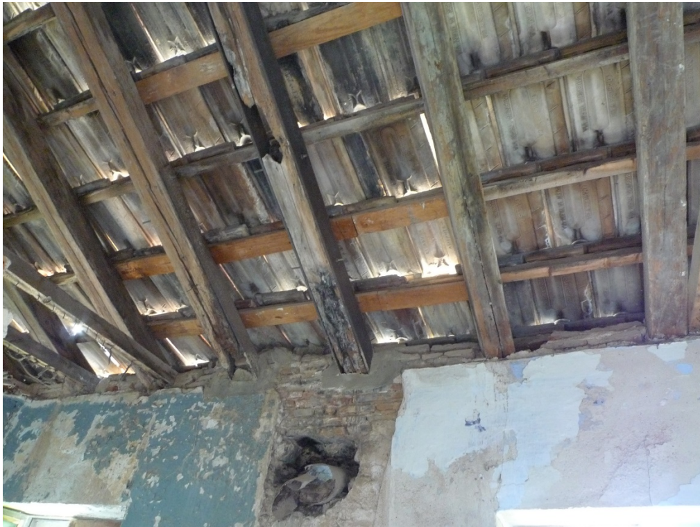
Figuras 93. Detalle reparación de vigueta de cubierta.
