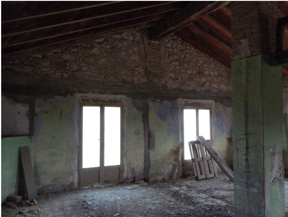
Figura 28. Vista interior de muro piñón. Bloque 1 fachada norte.
