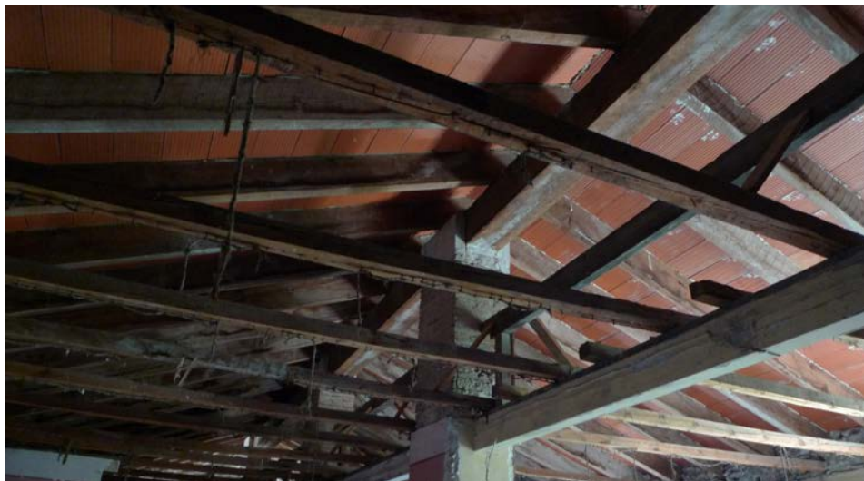
Figura 58. Vista general bajo cubierta Bloque 2
