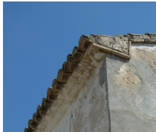
Figura 53. Cornisa fachada trasera
