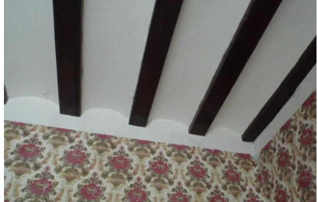
Figura 35. Vista cara inferior forjado.
