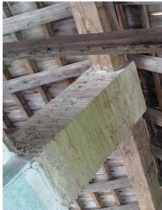
Figura 22. Pilar de 50x60 cm en planta alta.
