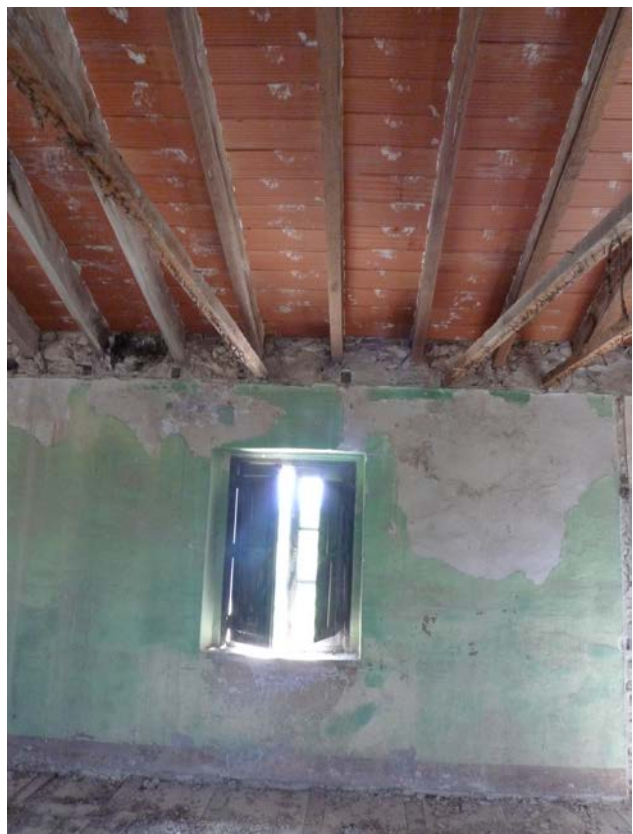
Figura 30. Relleno de piedra entre cabezas de vigueta.
