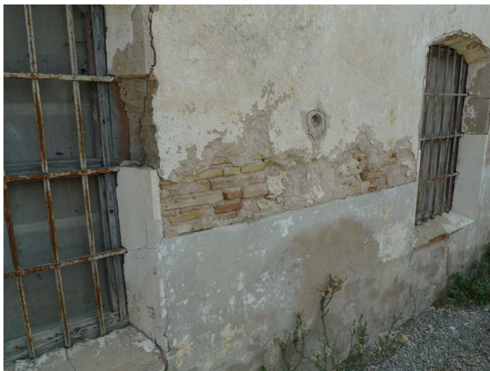
Figura 23. Machones de ladrillo en las jambas de las ventanas y trazas de ladrillo en los vierteaguas
