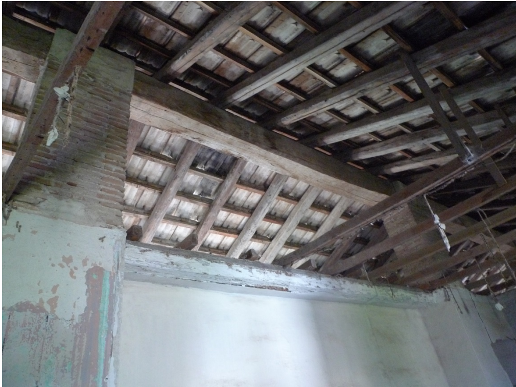
Figura 11. Bajo cubierta Bloque 3
