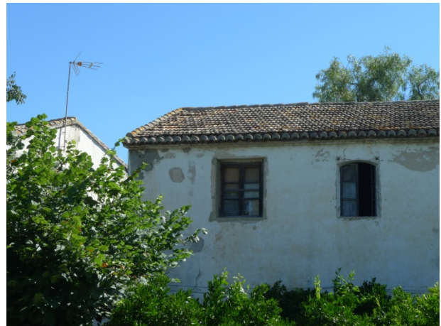
Figura 60. Vista general cobertura y remates
