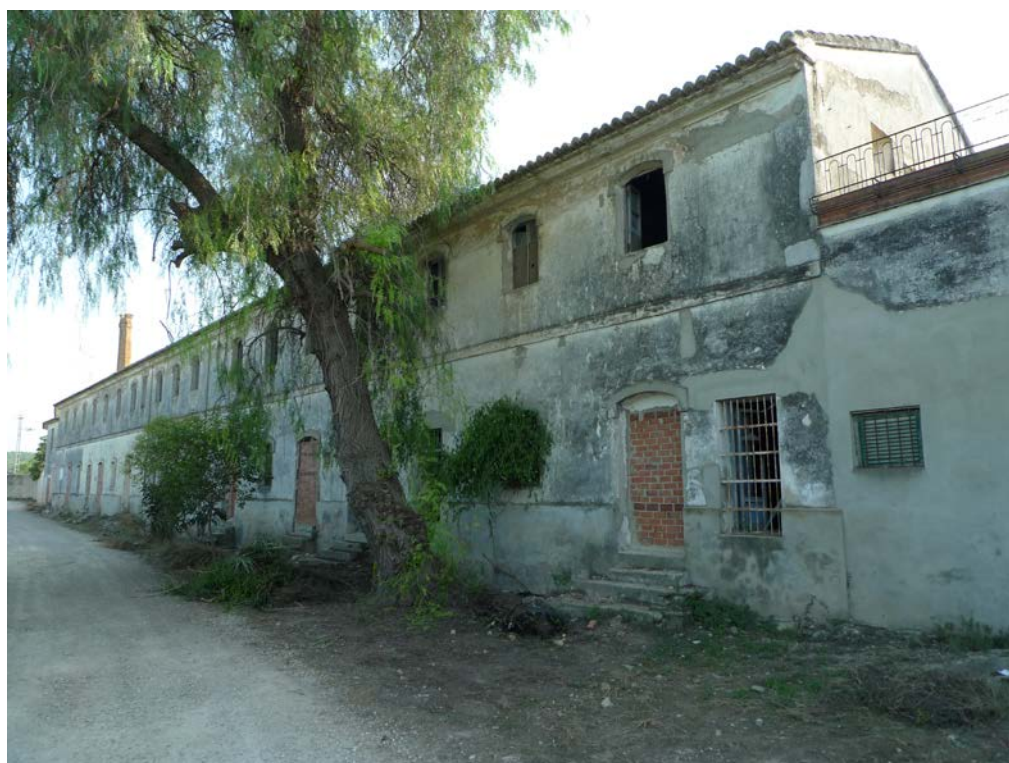
Figura 9. Vista general Boque 3 y Unión 2. Fachada Este.
