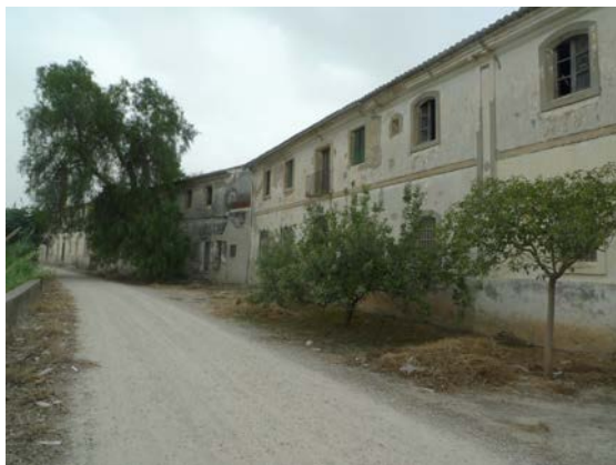
Figura 16. Bloque 2. Fachada Este.
