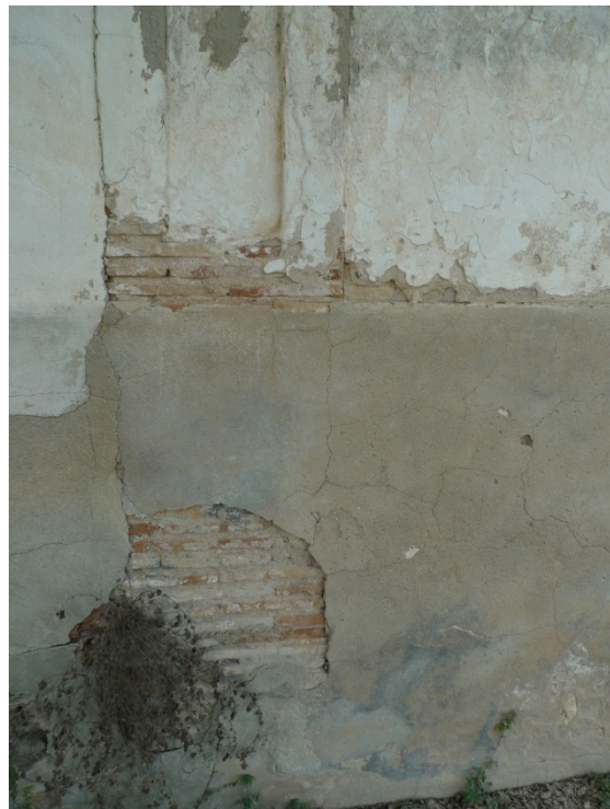
Figura 45. Zócalo y arranque de pilastra.
