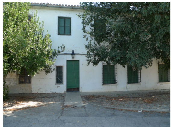
Figura 15. Bloque 2. Fachada trasera, zona derecha. Acceso a vivienda independiente.
