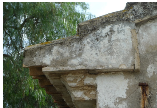
Figura 62. Detalle albardilla y remate lateral
