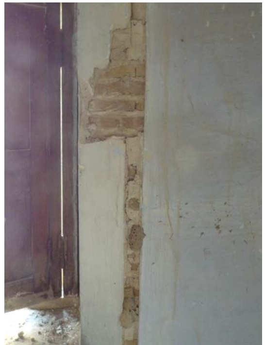
Figuras 26 y 27. Detalle de machón de ladrillo formando jambas de ventana.
