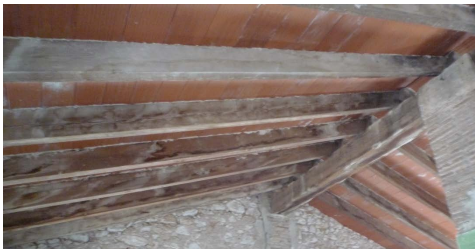
Figura 59. Vista general bajo cubierta Bloque 1
