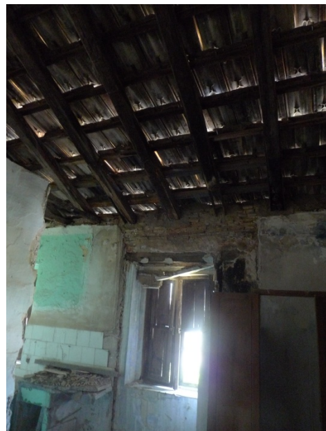
Figuras 91 y 92. Viguetas de madera de cubierta quemadas.
