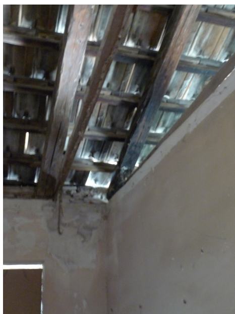
Figuras 91 y 92. Viguetas de madera de cubierta quemadas.
