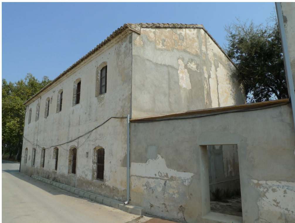
Figura 8. Vista general Boque 1 y Unión 1. Fachada Oeste.
