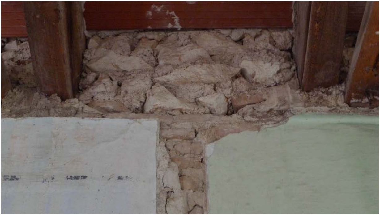
Figura 25. Verdugada superior de apoyo de viguetas.
