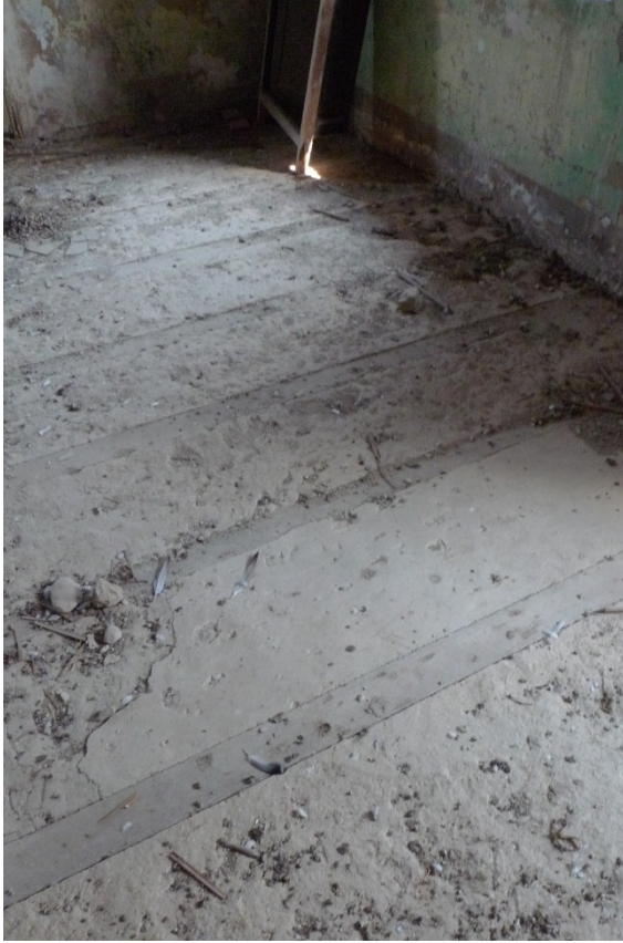
Figura 36. Cara superior de forjado sin pavimento.
