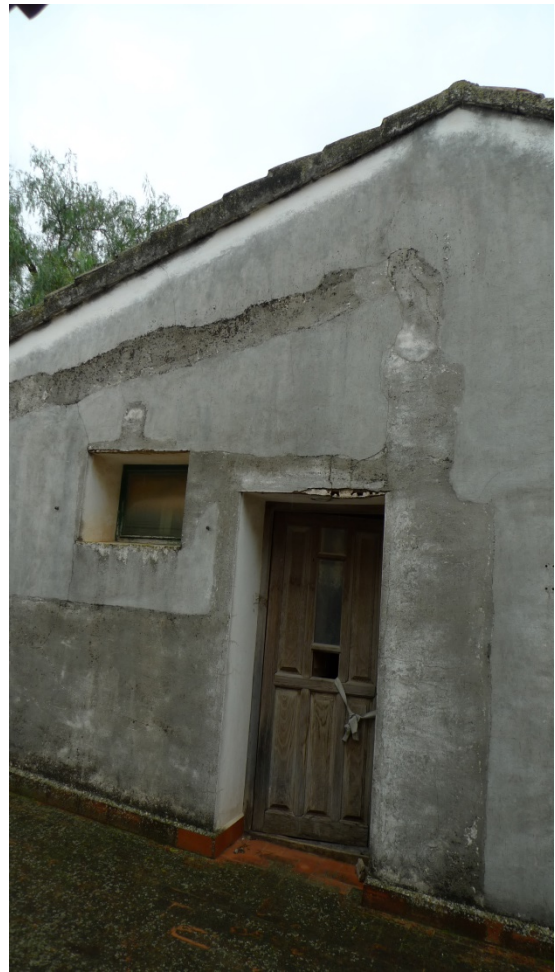
Figura 18. Bloque 3. Fachada Este.
