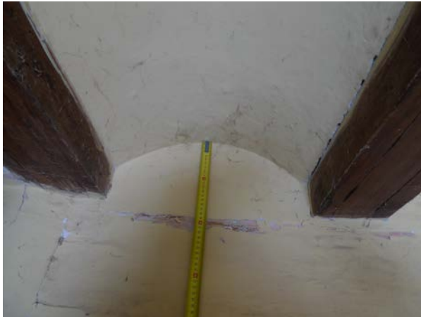
Figuras 89 y 90. Viguetas de madera de forjado de planta.
