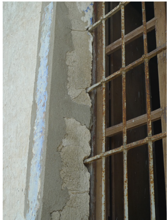
Figuras 96 y 97. Vistas de anclaje de rejillas al muro
