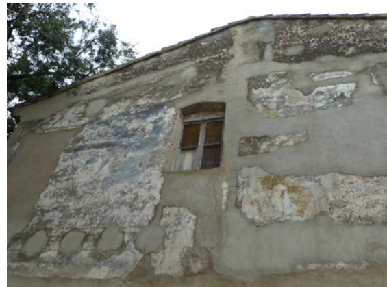
Figura 17. Bloque 2. Fachada Norte. Planta piso.
