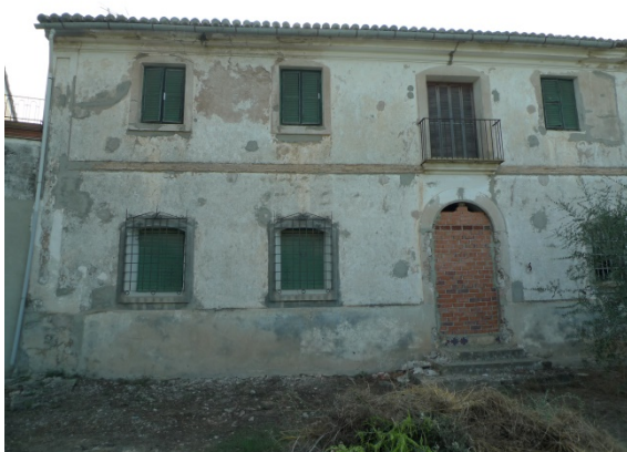
Figuras 101. Fachada Este. Bloque 2
