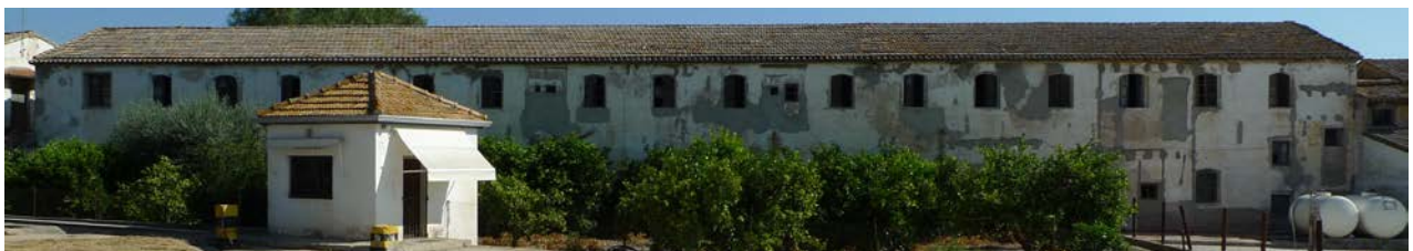
Figura 20. Bloque 3. Panorámica Fachada Oeste.
