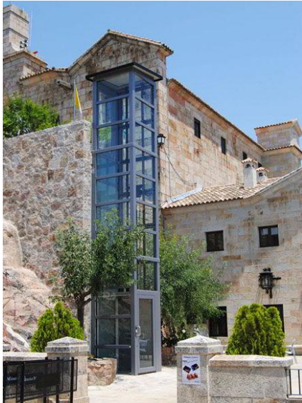
99. Ejemplo sistema elevador por fachada. 2017. Fuente: www.gexxi.com
