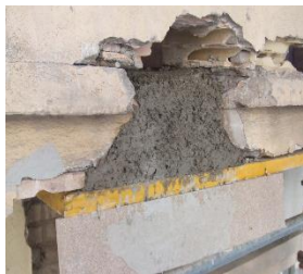
96. Secuencia de reparación de forjado afectado por corrosión. 2017. Fuente: Construcción VI.
