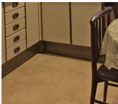
077. Pavimento cocina 1. 2017. Fuente: Autor.
