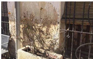
93. Fachada norte de la vivienda. 2017. Fuente: Autor.
