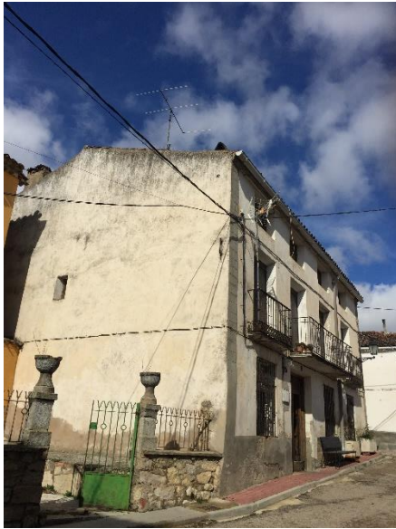
045. Fachada colindante con la parcela contigua. 2017. Fuente: Autor.
