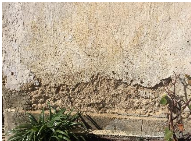
92. Fachada este de la vivienda. 2017. Fuente: Autor.
