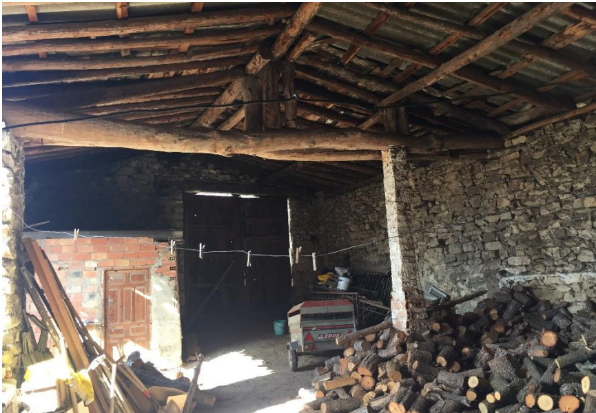
065. Cubierta Corral. 2017. Fuente: Autor.
