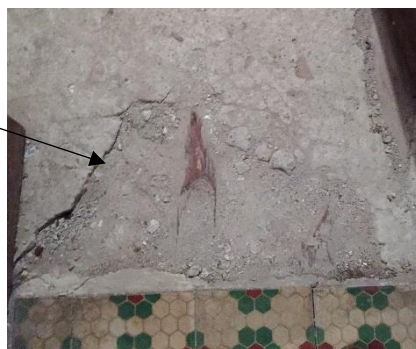
101. Forjado sin terminar. 2017. Fuente: Autor.
