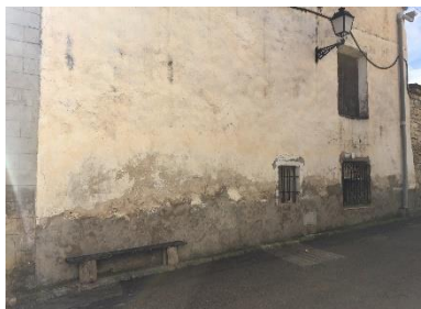
94. Fachada norte de la vivienda. 2017. Fuente: Autor.
