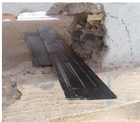
96. Secuencia de reparación de forjado afectado por corrosión. 2017. Fuente: Construcción VI.
