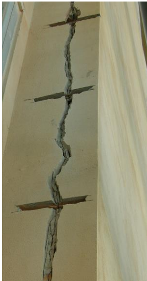
091. Ejemplo de cosido de grieta. 2017. Fuente:www.isotecsl.com.
