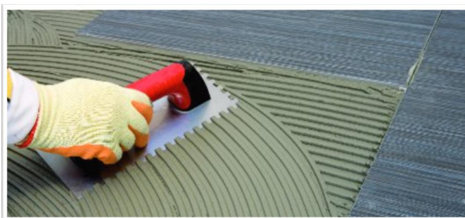
Figura 31. Colocación de gres, 2017, www.weber.es
