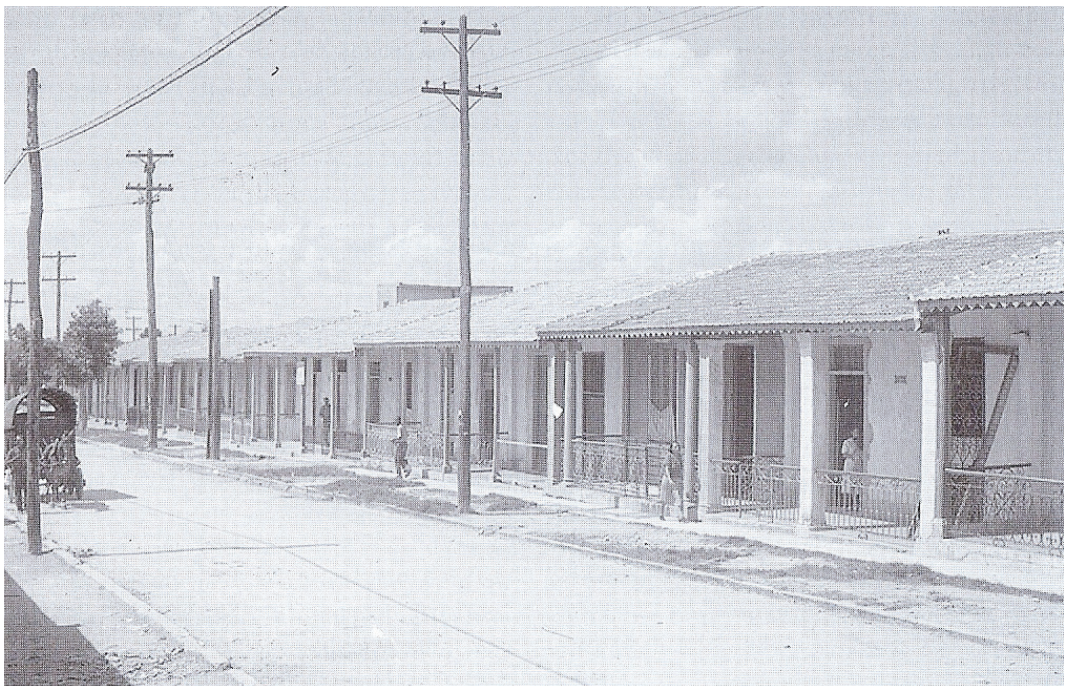
43. Barrio Obrero de Pogolotti en el Reparto de Marianao, La Habana, en una fotografía de 1948. (AJC)
