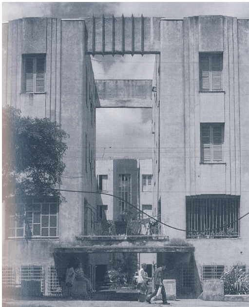
31. Emilio de Soto. Edificio de apartamentos Santeiro (1937) en el Vedado, La Habana. (RS)
