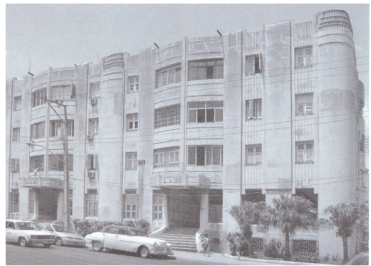
40. Rivero y Fontán. Edificio de apartamentos (1941) en el Vedado, La Habana. (RS)
