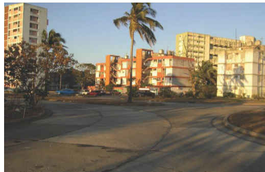
141. Reparto Alamar y Reparto Camilo Cienfuegos en La Habana del Este. (I)
