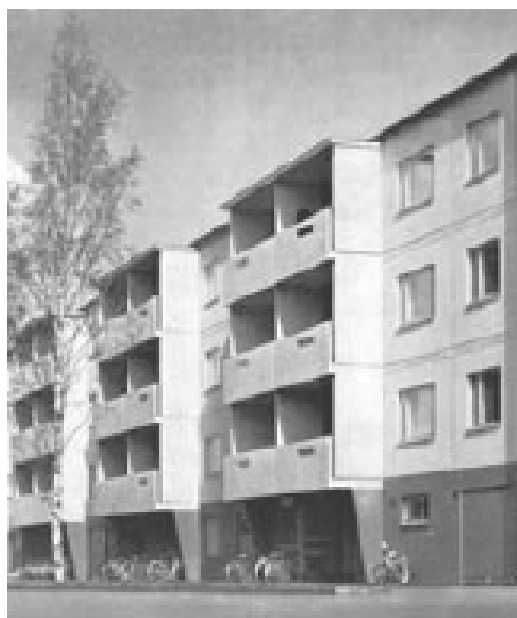
130. Edificio de 4 plantas en construcción con el Sistema Gran Panel 70. (JR)
