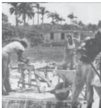
131. Microbrigadas de autoconstrucción. (ETH)
