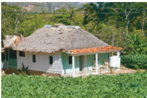
134. Arquitectura rural cubana. Bohío en Pinar del Río. (DGC)
