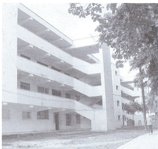
62. Vista de uno de los bloques de vivienda colectiva del Barrio Obrero de Luyanó. (FG)
