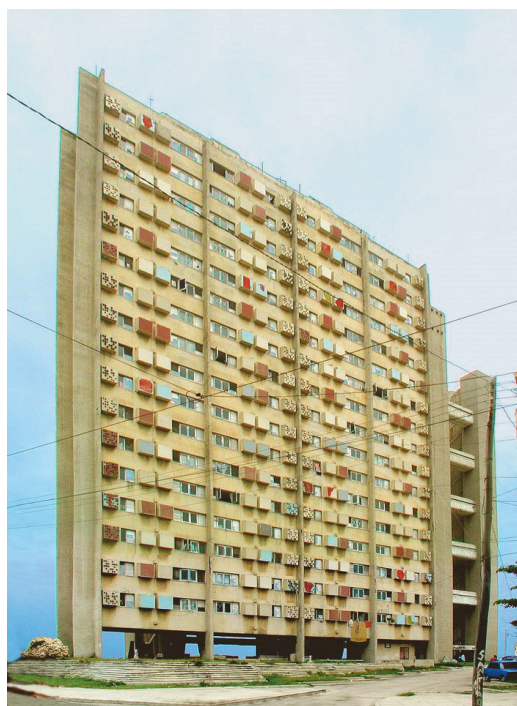
118. Antonio Quintana. Edificio Experimental de 17 plantas. Fachada hacia la ciudad. (I)
