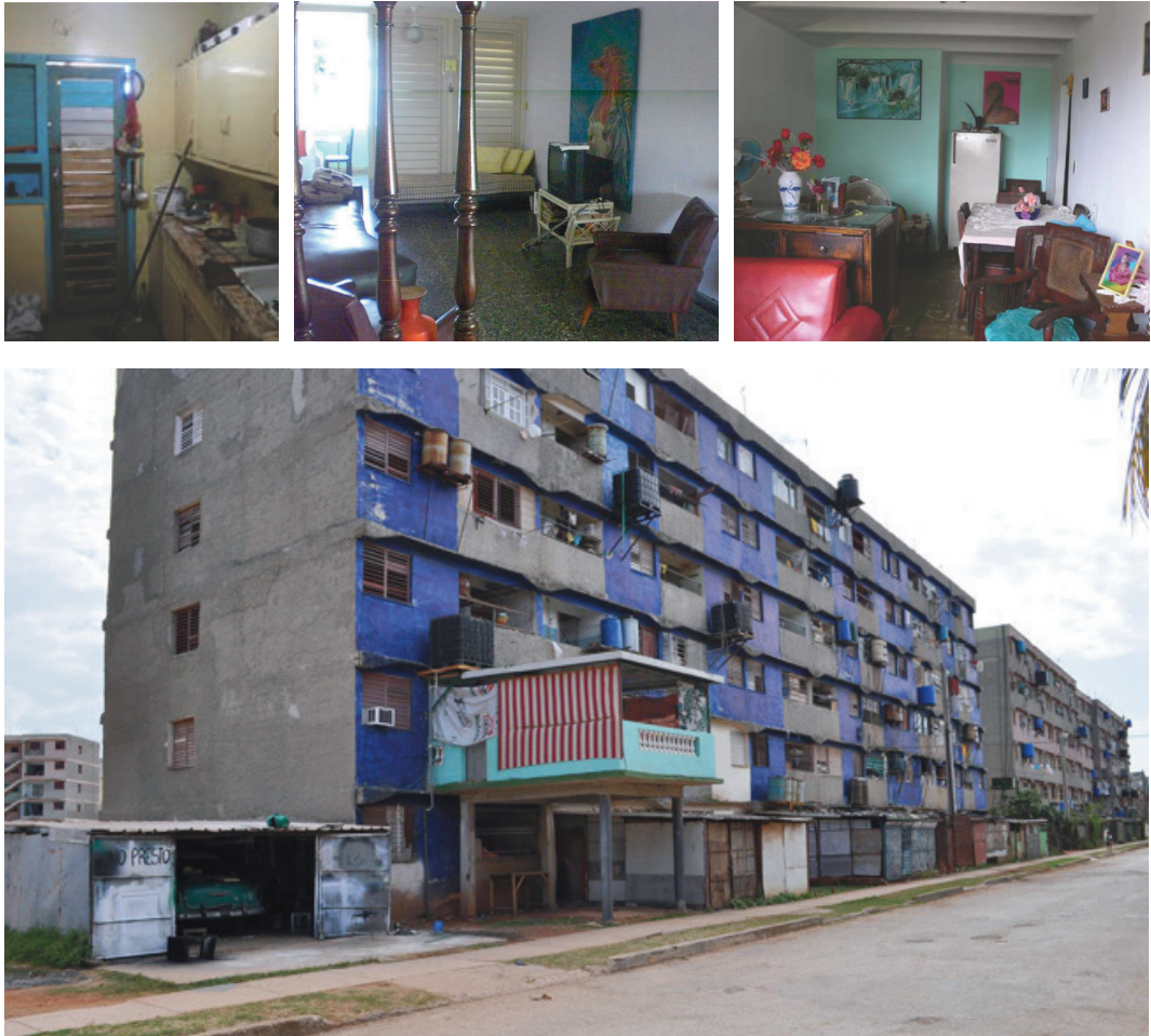
208. Ejemplos de alteración en los interiores de unas viviendas y en la fachada de un edificio en Alamar. (I) (ETH)
