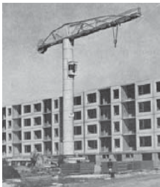
127. Edificio de 5 plantas en construcción con el Sistema LH. (JR)
