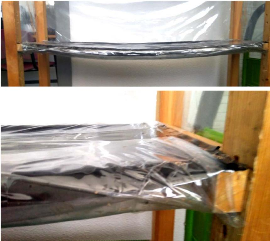
*Figura 246. Vista general y en detalle del cierre con doble capa de plástico realizado en la parte inferior de la zona de secado*
