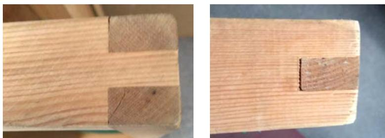
*Figura 49. Uniones entre listones, tipo caja y espiga*
