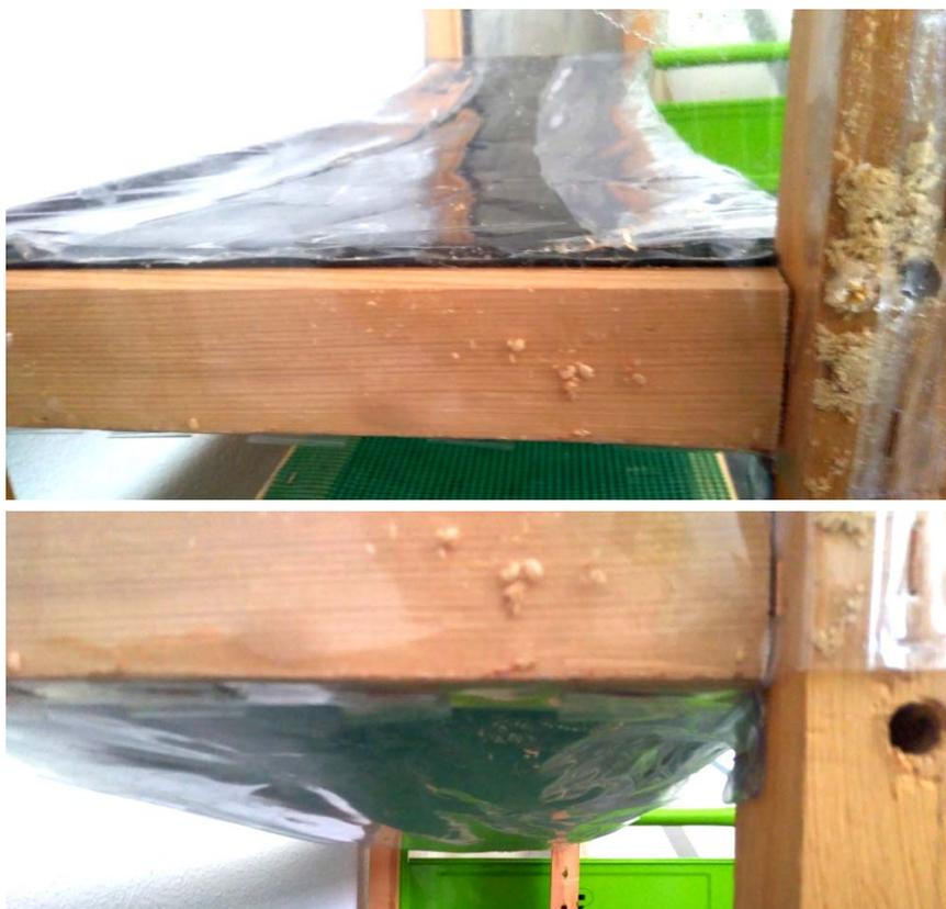
*Figura 247. Vistas de detalle desde el lateral de la parte superior e inferior del cierre con doble capa de plástico de la parte de abajo de la zona de secado*
