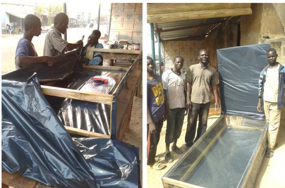
*Figura 160. Proceso de colocación del plástico sobre la estructura del colector y equipo completamente terminado (Lozano, I. 2013)*
