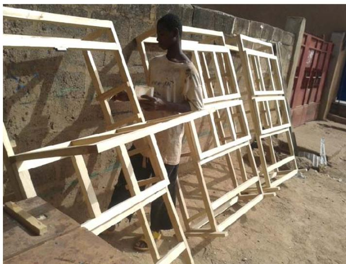
Figura 180. Armazón de la cámara de secado, construida con puertas traseras para la entrada y salida de las bandejas (Lozano, I. 2013)
