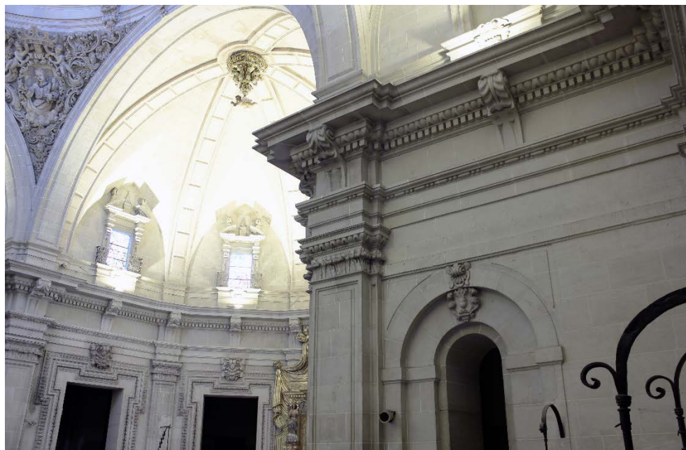
Figura II.1.4. Detalle de la cornisa y bóveda del ábside.
