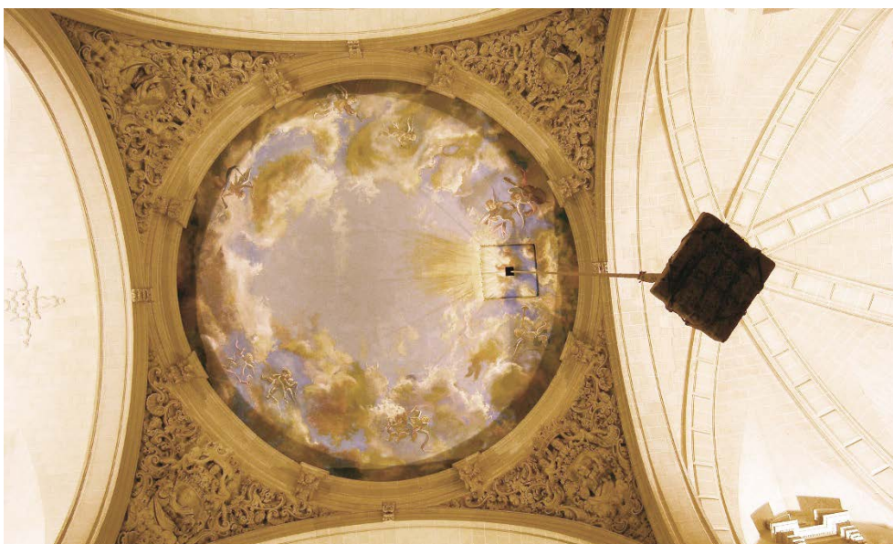
Figura IV.2.2.3. Detalle de la cúpula cubierta por la lona del cielo.
