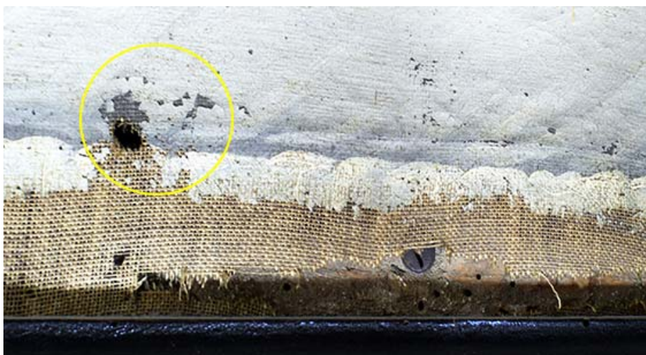
Figura 69. Estado de conservación actual. Perímetro inferior de la Sagrada Familia con Santa Ana y San Juanito .
