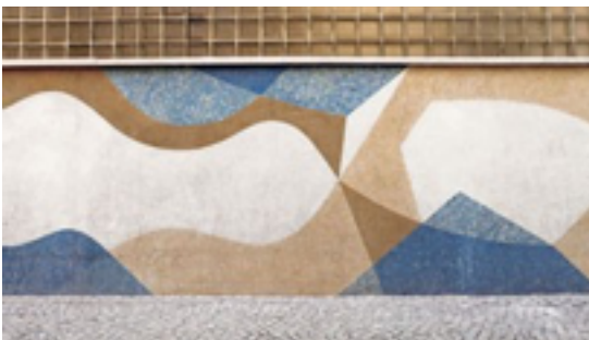
fig.179 Banco Boavista, detalle del panel cerámico junto acceso.
