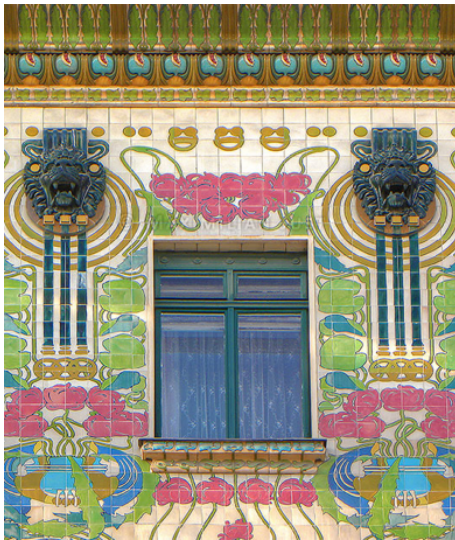
fig.13 Edificio en Avenue Rapp, 29 de París, de Jules Lavirotte. fig.14 Majolica House en Viena, de Otto Wagner.
