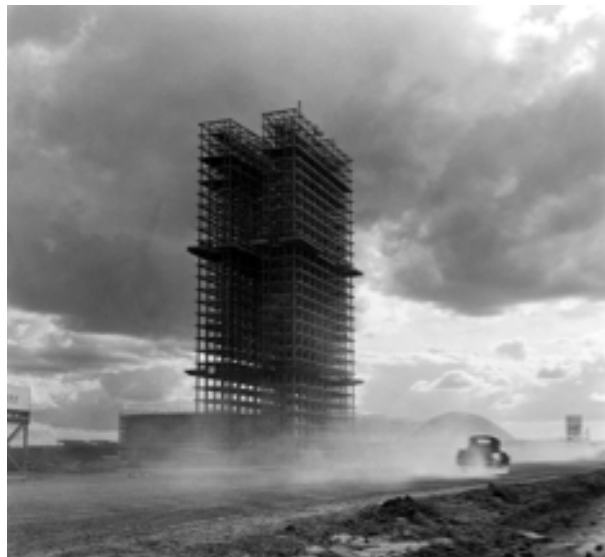
fig.187 Brasilia en construcción. Edificio del Congreso Nacional.
