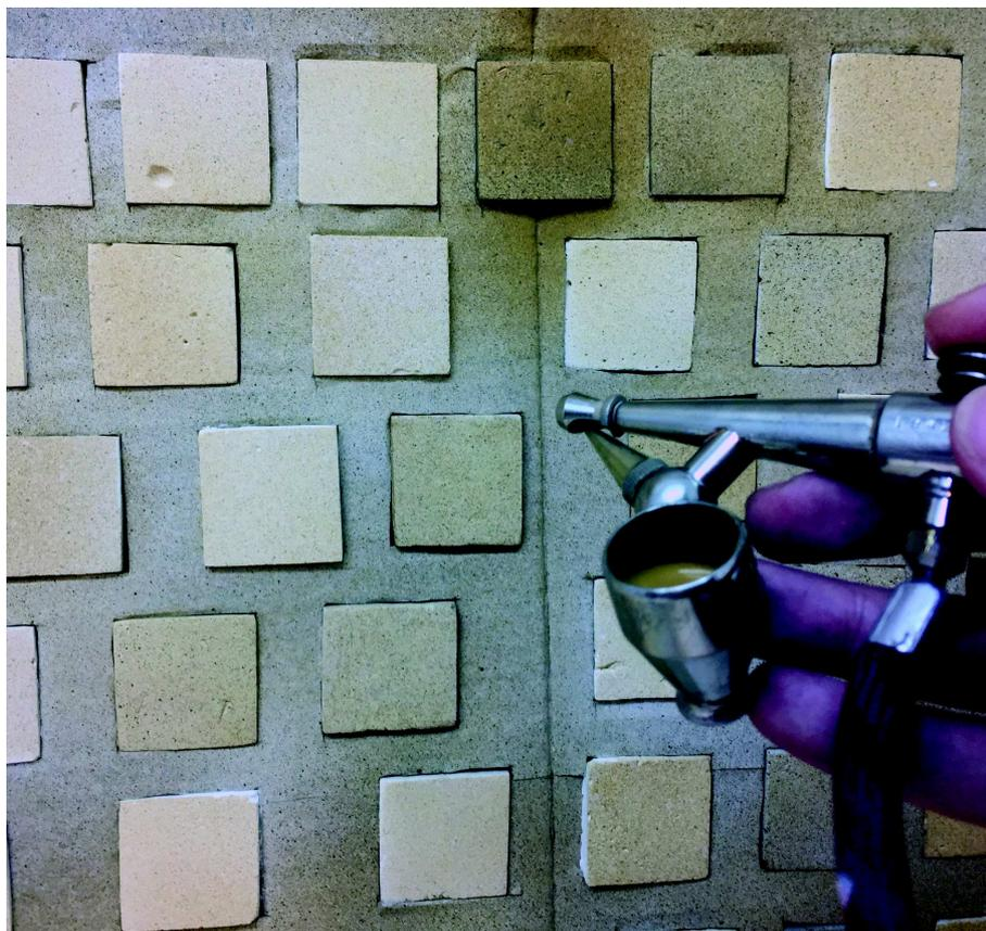
**Imagen 5.8. Proceso reintegración con aerógrafo.**
