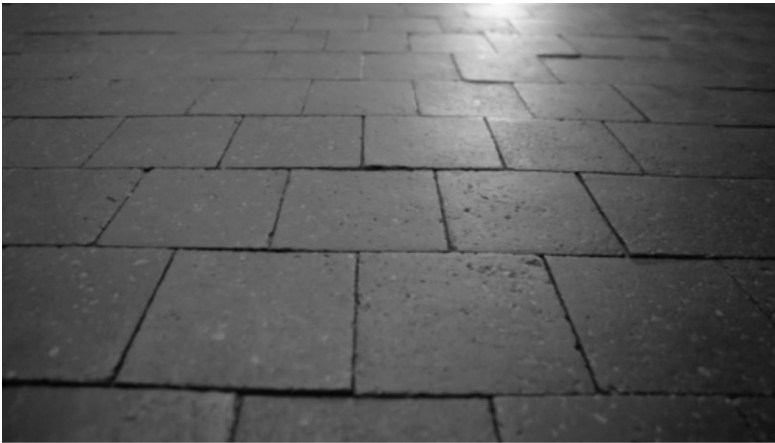
Figura 4.40. Detalle del suelo de baldosa cerámica de la Rothko Chapel. La construcción de la capilla siempre mantuvo un espíritu austero y sencillo a través de la utilización de materiales básicos.
