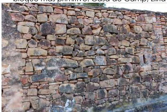
Fig. 275. Cuidado aparejo en el muro de cerramiento del patio. Mas de Ferriol, Llíria.
