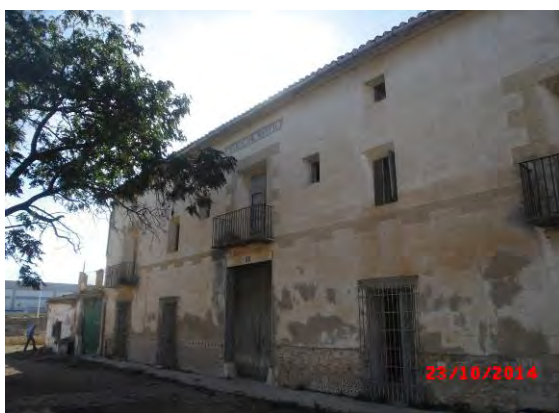
Fig. 191. Fachada bloque residencial
