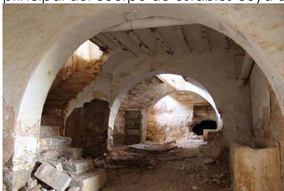
Fig. 66. Zona de aljibes en la parte más primitiva del conjunto
