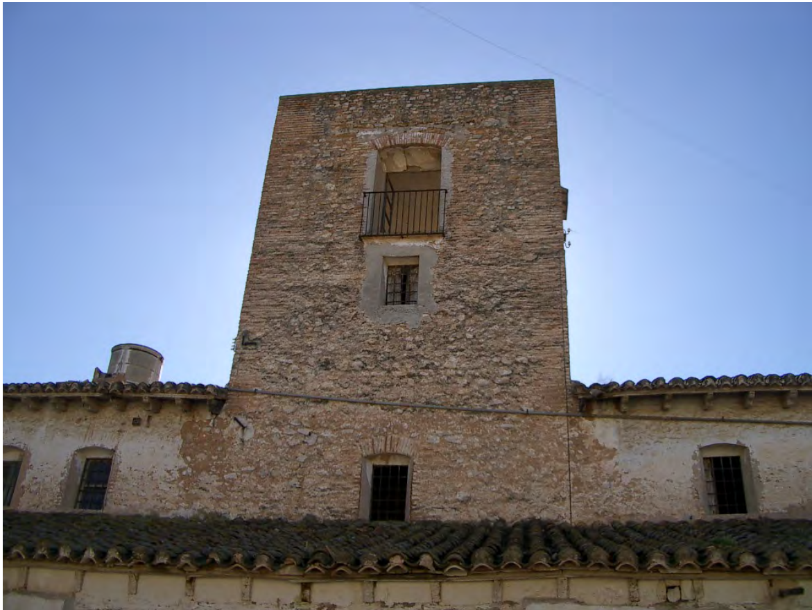
Fig. 185. Detalle torre desde el patio. Ayuntamiento.
