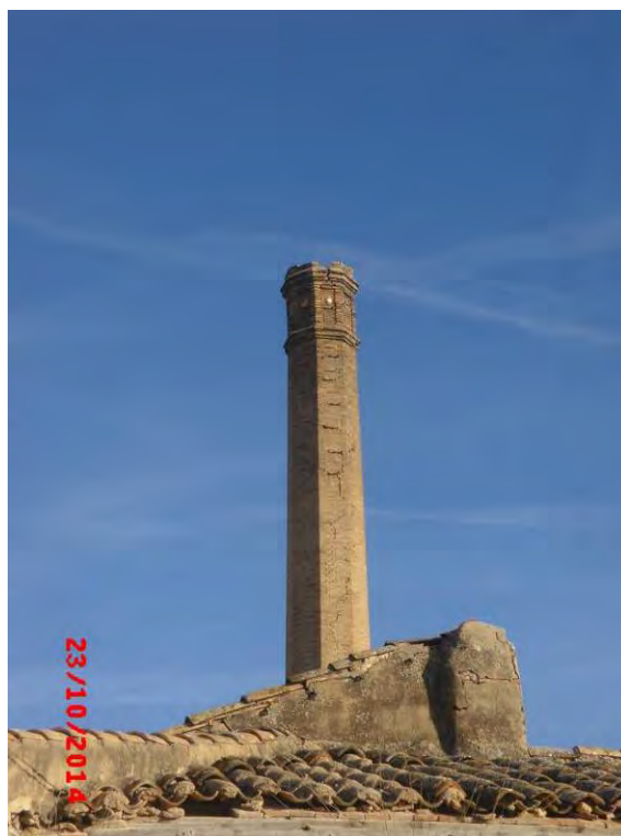
Fig. 225. Detalle de la chimenea.
