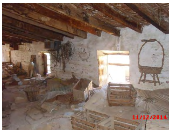
Fig. 201. Espacio bajo cubierta.
