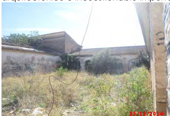
Fig. 216. . Patio interior dividido.
