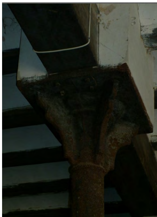
Fig. 169. Capitel metálico que sustenta a un forjado de vigas y viguetas de madera.
