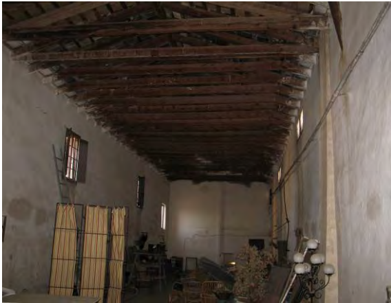
Fig. 239. Cubierta triangulada del edificio productivo
