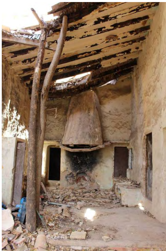
Fig. 158. Zona de la "llar" en planta baja.
