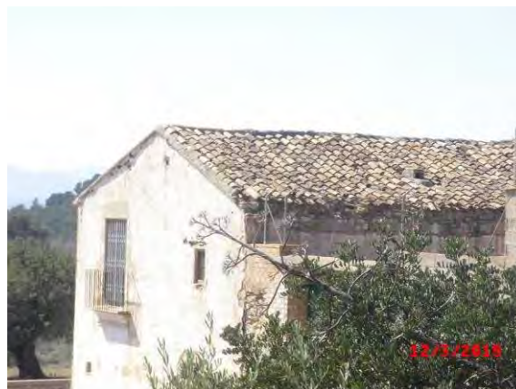
Fig. 114. Cubierta del volumen a dos aguas
