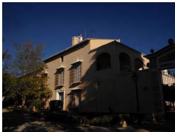
Fig. 97. Detalle de huecos de la fachada
