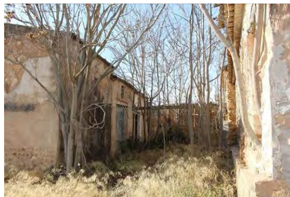
Fig. 155. Vista calle casas de los temporeros
