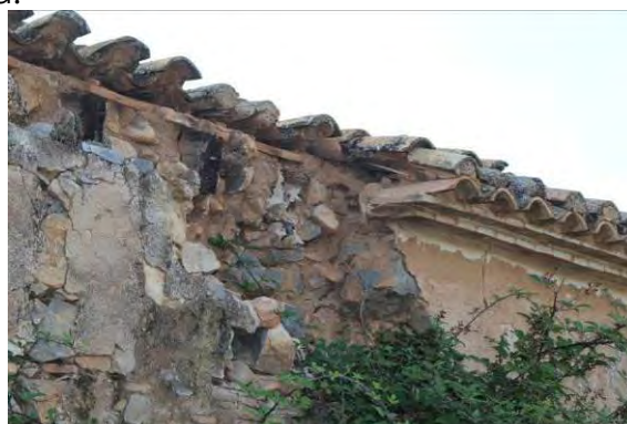
Fig. 77. Detalle alero en ruina. Determina el modo de construirse.
