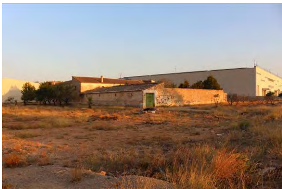
Fig. 208. Estado actual del edificio entre naves industriales
