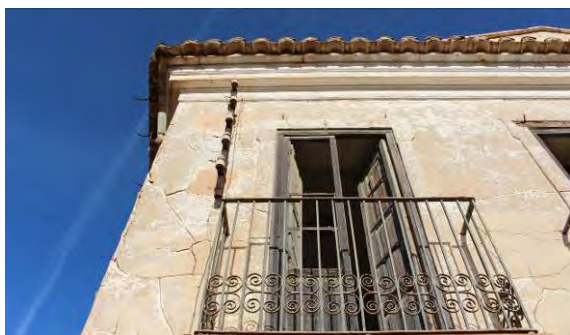
Fig. 141. Imagen del punto de contacto entre fases
