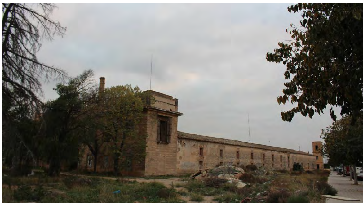
Fig. 212. Imagen actual del edificio inserto en una trama urbana industrial.
