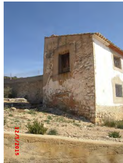
Fig. 116. Testero edificio principal
