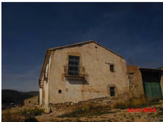
Fig. 113. Testero edificio principal
