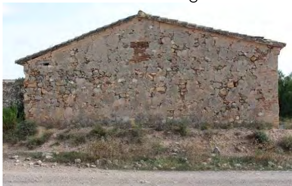
Fig. 76. Materialidad del testero de uno de los edificios económicos.
