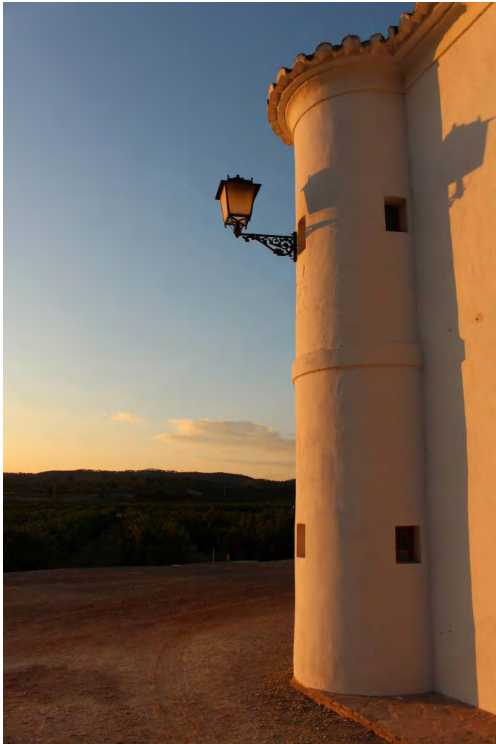
Fig. 132. Detalle del garitón de esquina y su relación con el territorio circundante y en especial con el acceso tradicional a la masía
