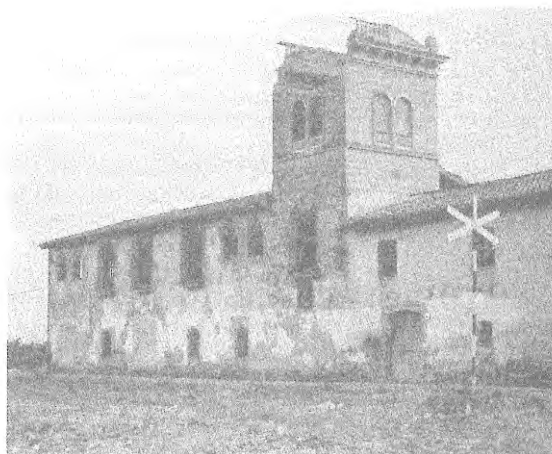
Fig. 46. Masía de la Torre del Virrey de l'Eliana, muestra su estado ruinoso a principios de los años ochenta. Este edificio es testimonio de los inicios de la propia población. 75 . Hoy se encuentra rehabilitada y en uso.
