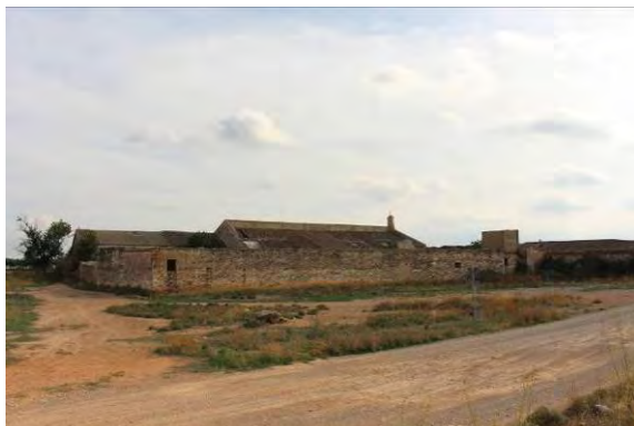
Fig. 62. Volumetría del conjunto desde el norte.
