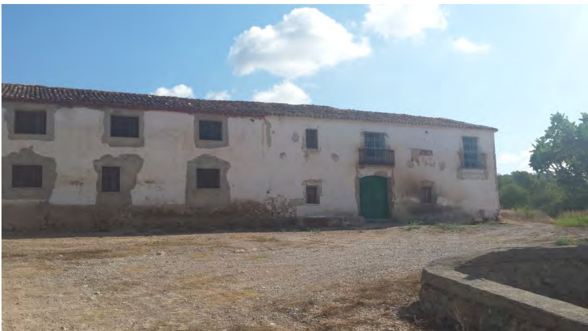
Fig. 109. Fachada principal hace algunos años. Ayuntamiento
