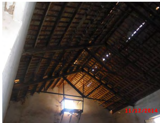
Fig. 199. Cubierta a dos aguas con cercha metálica en volumen productivo situado al oeste
