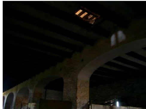
Fig. 184. Estructura interior. Ayuntamiento
