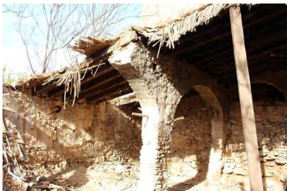
Fig. 156. Detalle estructura de los establos.
