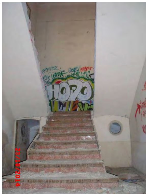
Fig. 224. Escalera principal bajo en la torre.
