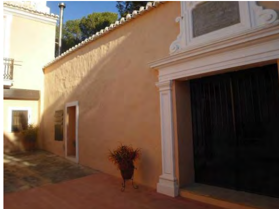
Fig. 103. Fachada a patio.
