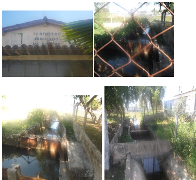
Figs. 11. Mosaico fotográfico- vista de la entrada principal del edificio del PIB y estructura de concreto con puertas de control de agua, PIB. (Foto: G.C.S. A., mayo, 2012).
