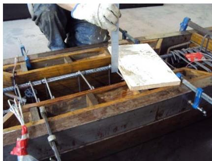
Figura IV.48: Comprobando el recubrimiento
