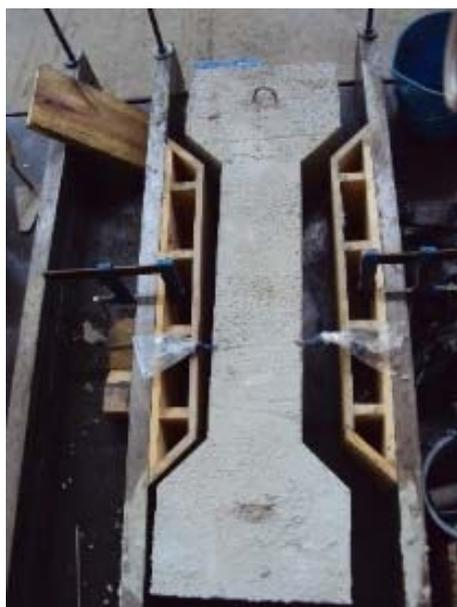
Figura IV.64: Elemento desencofrado
