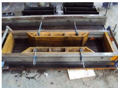
Figura IV.45: Encofrado preparado
