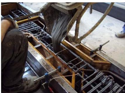
Figura IV.60: Llenado del encofrado
