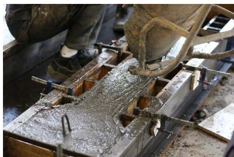
Figura IV.61: Finalización del hormigonado
