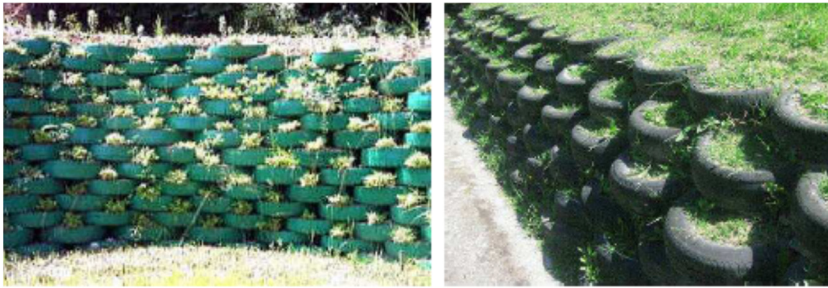
Figura 2.9 Muro de contención hechos con NFU [54]
