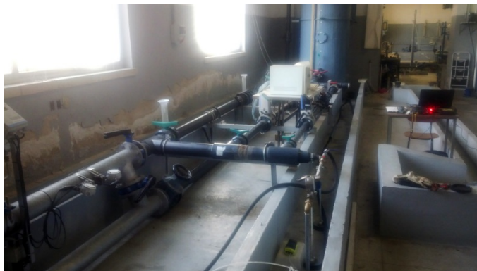
Imagen 2. Banco de ensayos para ramales.
