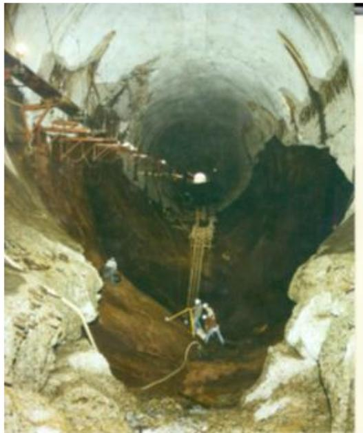
**Figura 2: Daño por cavitación en el órgano de desagüe de la presa de Glen Canyon, EEUU en 1983 [4]. El agujero tiene una profundidad de 11m.**
