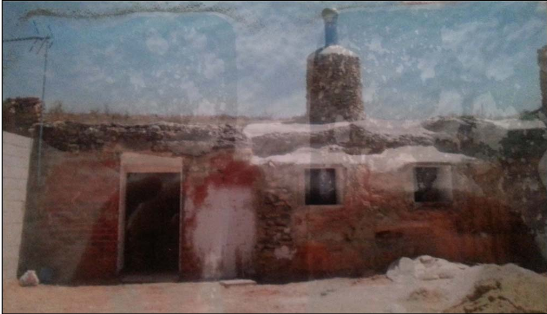
Figura 39. Proceso de construcción de la fachada. Casa-cueva nº3
