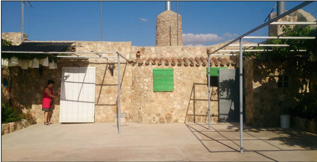
Figura 40. Fachada terminada. Casa-cueva nº3.
