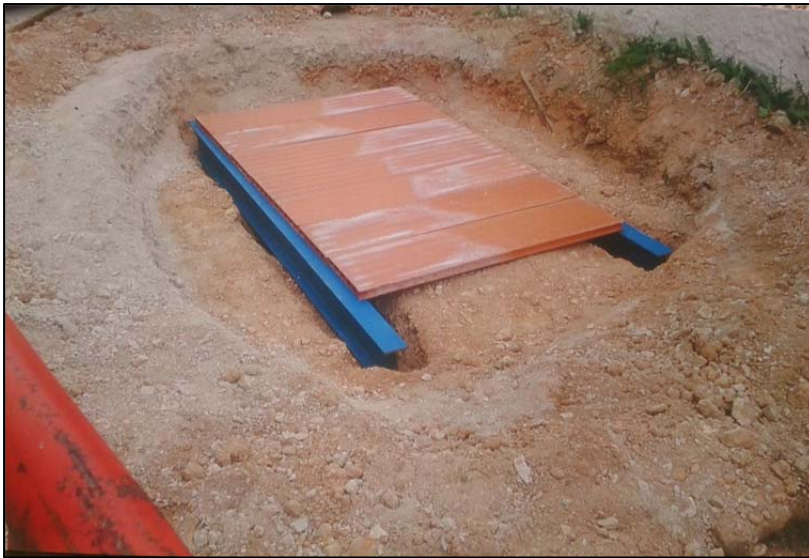
Figura 101. Huevo de chimenea después de ser derribado.
