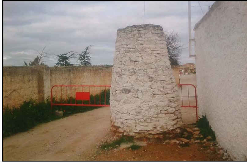
Figura 100. Chimenea antes de ser derribada.
