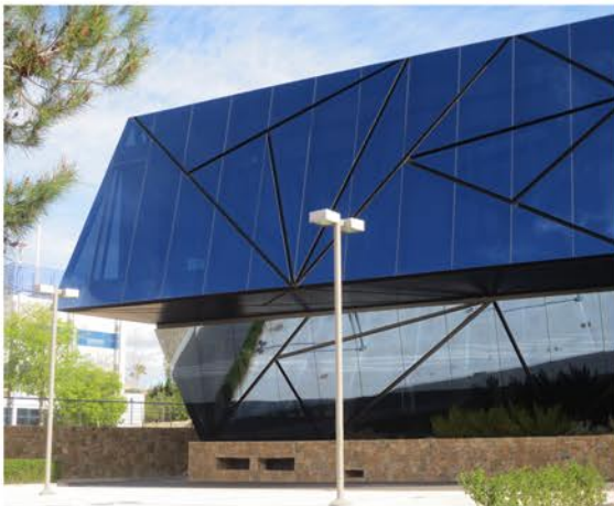
Imagen 70. Vista general del edificio. Fuente propia.
