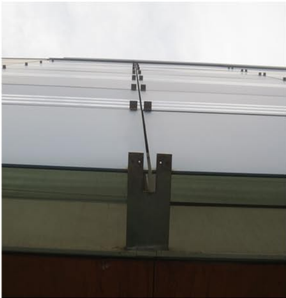
Imagen 83. Anclaje fachada. Fuente propia.
