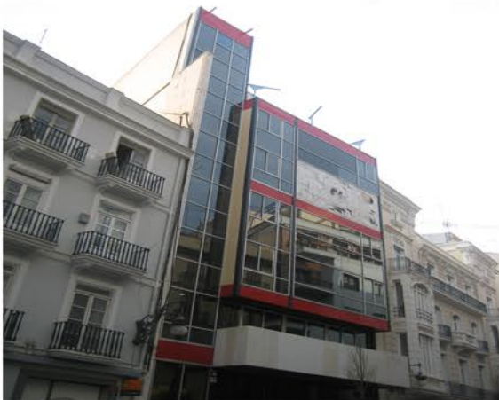
Imagen 67. Vista general del edificio. Fuente propia.
