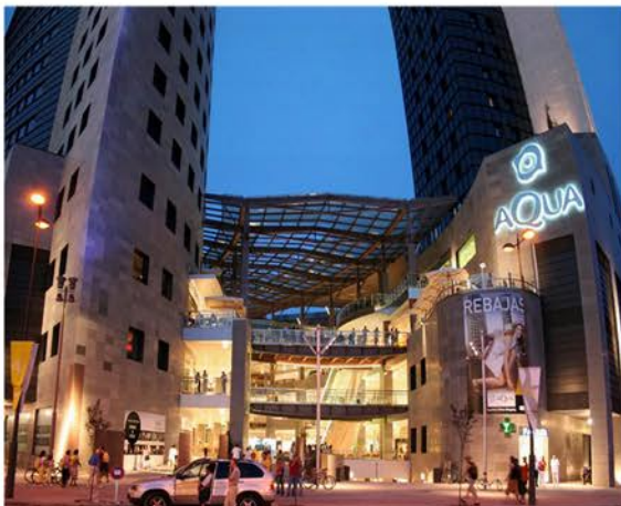
Imagen 82. Vista general del edificio. Fuente propia.
