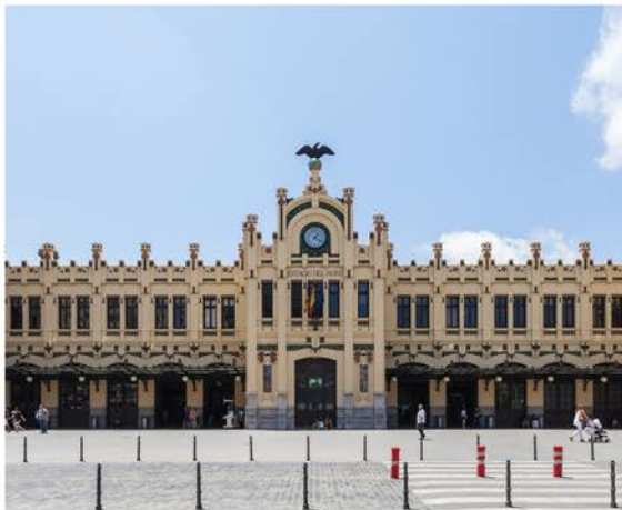
Imagen 40. Vista general del edificio. Fuente propia
