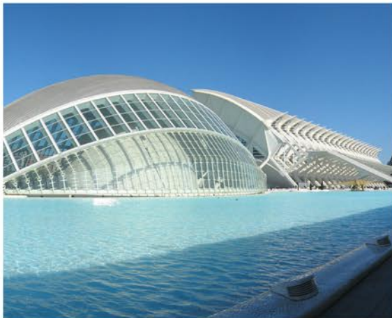
Imagen 38. Vista general del edificio. Fuente propia.
