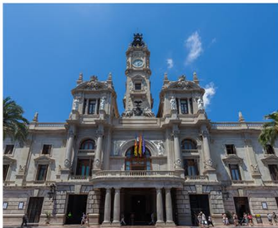
Imagen 59. Vista general del edificio. Fuente propia.
