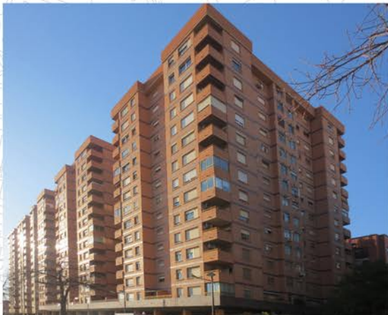
Imagen 35. Vista general del edificio. Fuente propia.
