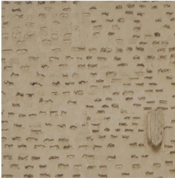
Imagen 1. Tapia valenciana de ladrillo. Fuente propia.
