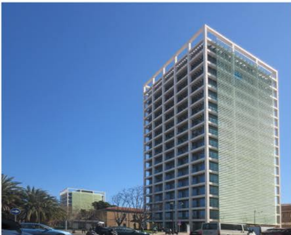
Imagen 74. Vista general del edificio. Fuente propia.
