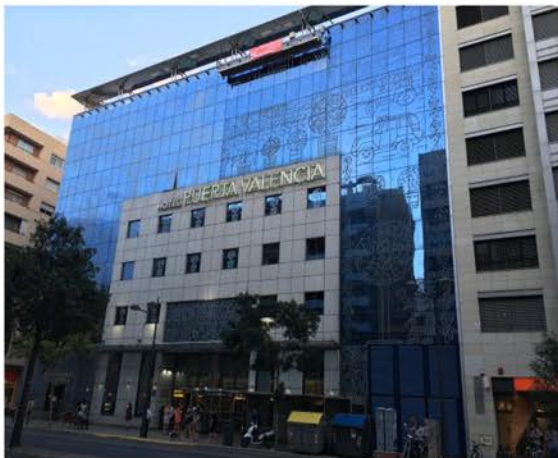
Imagen 63 Vista general del edificio. Fuente propia.
