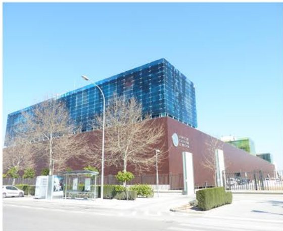
Imagen 65. Vista general del edificio. Fuente propia.
