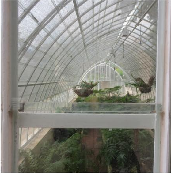
Imagen 56. Detalle carpintería y vidrio. Fuente propia.
