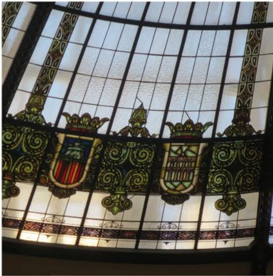
Imagen 60. Claraboya de vidrio. Fuente propia.
