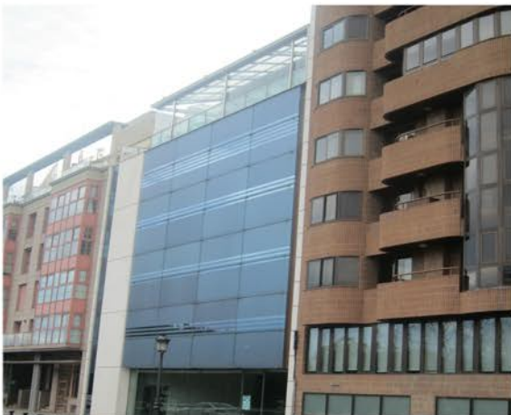
Imagen 84. Vista general del edificio. Fuente propia.
