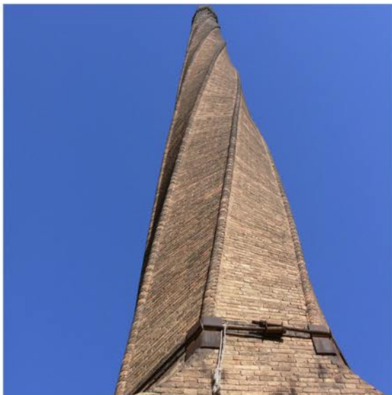
Imagen 11. Ladrillos aplantillados. Fuente propia.
