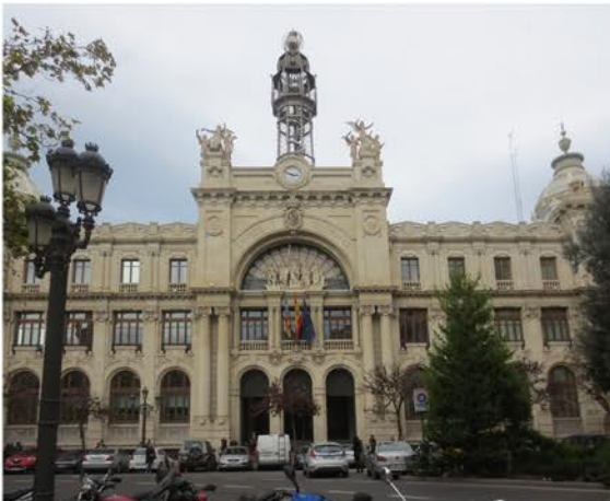
Imagen 47. Vista general del edificio. Fuente propia.
