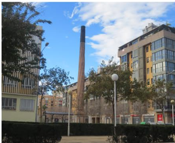
Imagen 12. Vista general de la chimenea. Fuente propia.
