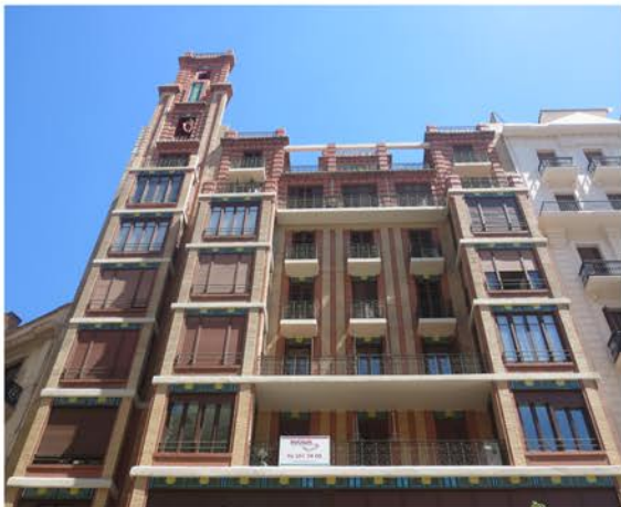
Imagen 16. Vista general del edificio. Fuente propia.
