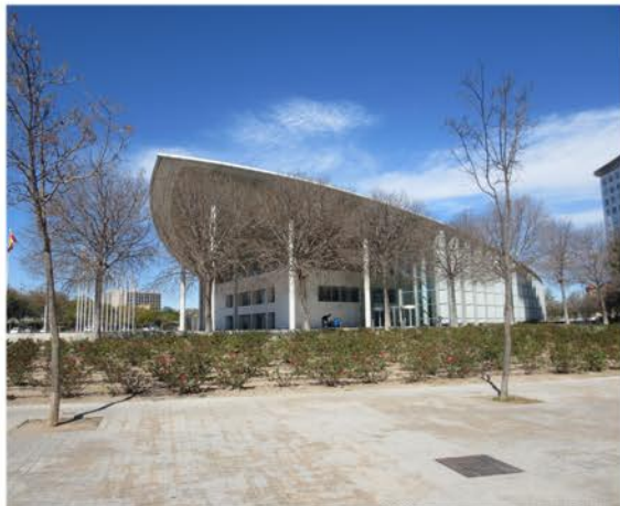
Imagen 72. Vista general del edificio. Fuente propia.
