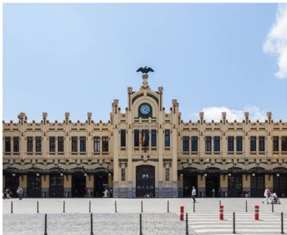
Imagen 19. Vista general del edificio. Fuente propia
