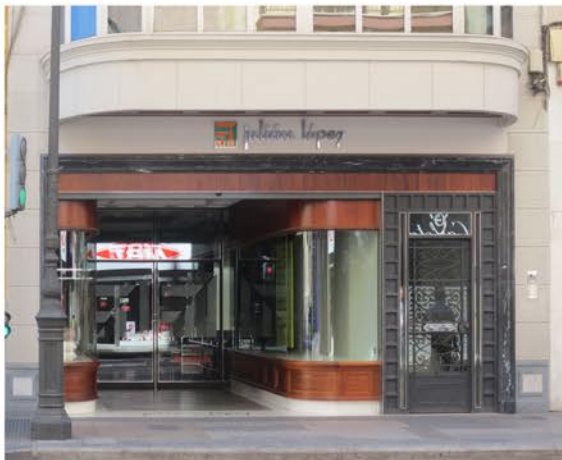
Imagen 86. Vista general del edificio. Fuente propia.
