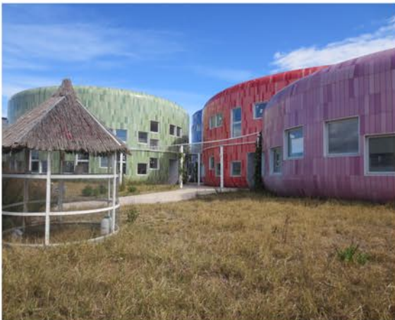
Imagen 49. Vista general del edificio. Fuente propia.
