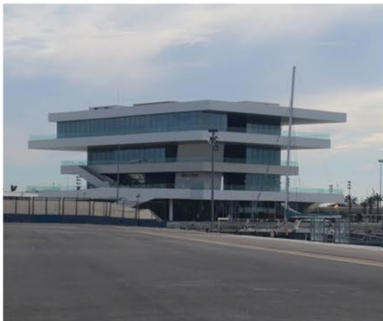
Imagen 77. Vista general del edificio. Fuente propia.
