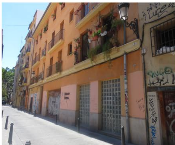
Imagen 88. Vista general del edificio. Fuente propia.
