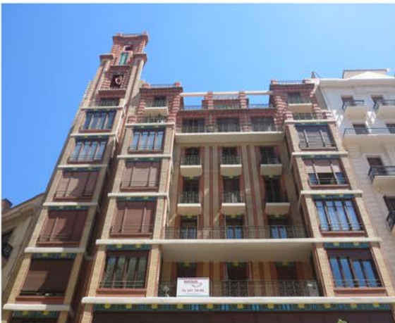
Imagen 31. Vista general del edificio. Fuente propia.
