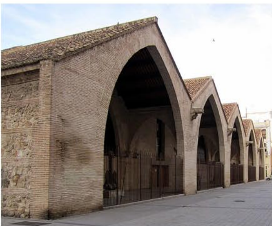
Imagen 5. Vista general del edificio. Fuente propia.
