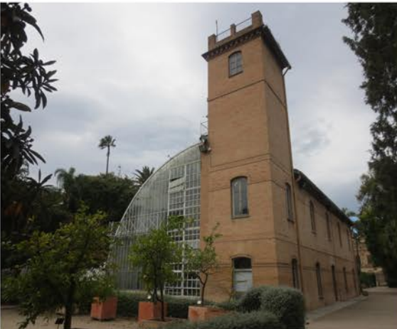
Imagen 57 Vista general del edificio. Fuente propia.
