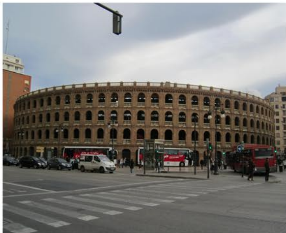
Imagen 10. Vista general del edificio. Fuente propia.
