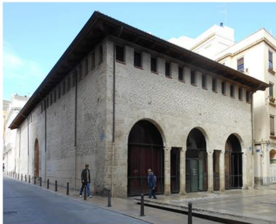
Imagen 2. Vista general del edificio. Fuente propia.
