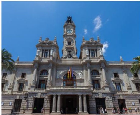
Imagen 43. Vista general del edificio. Fuente propia.
