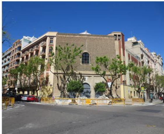
Imagen 7. Vista general del edificio. Fuente propia.
