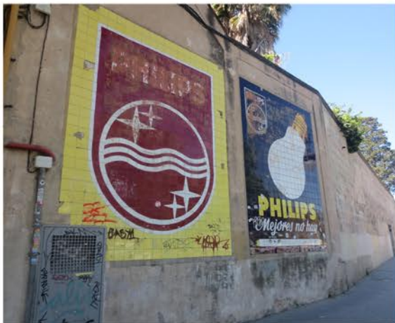
Imagen 28. Vista general de los paneles. Fuente propia.
