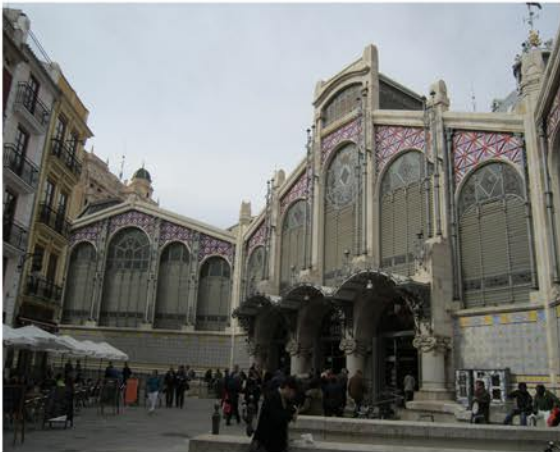
Imagen 24. Vista general del edificio. Fuente propia.
