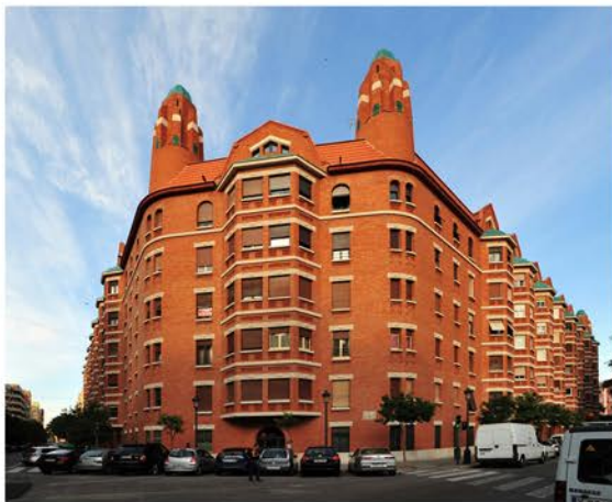
Imagen 14. Vista general del edificio. Fuente propia.
