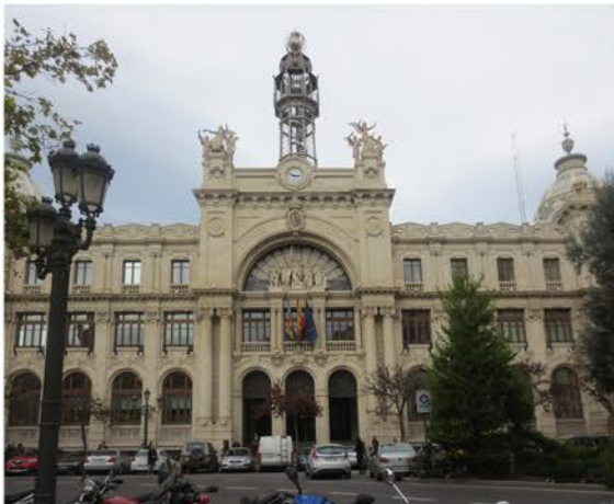
Imagen 61. Vista general del edificio. Fuente propia.
