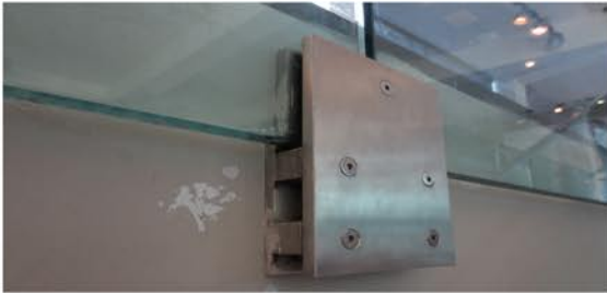
Imagen 78. Anclaje barandilla. Fuente propia.
