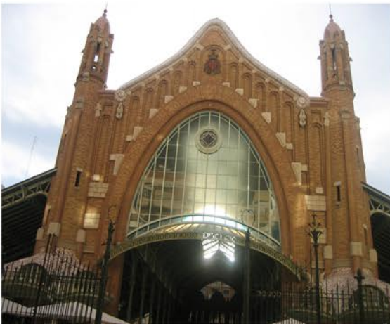
Imagen 26. Vista general del edificio. Fuente propia.
