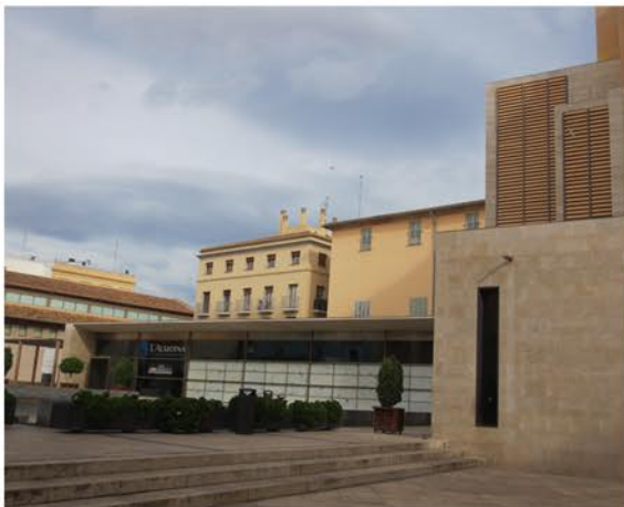
Imagen 80. Vista general del edificio. Fuente propia.
