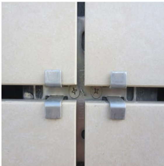
Imagen 50. Anclaje paneles de gres. Fuente propia.
