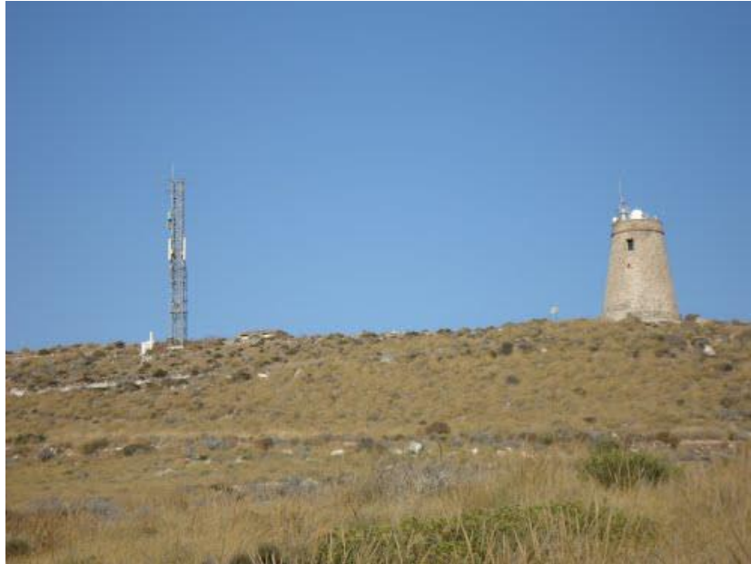
Fig.42 Torre de los Lobos
