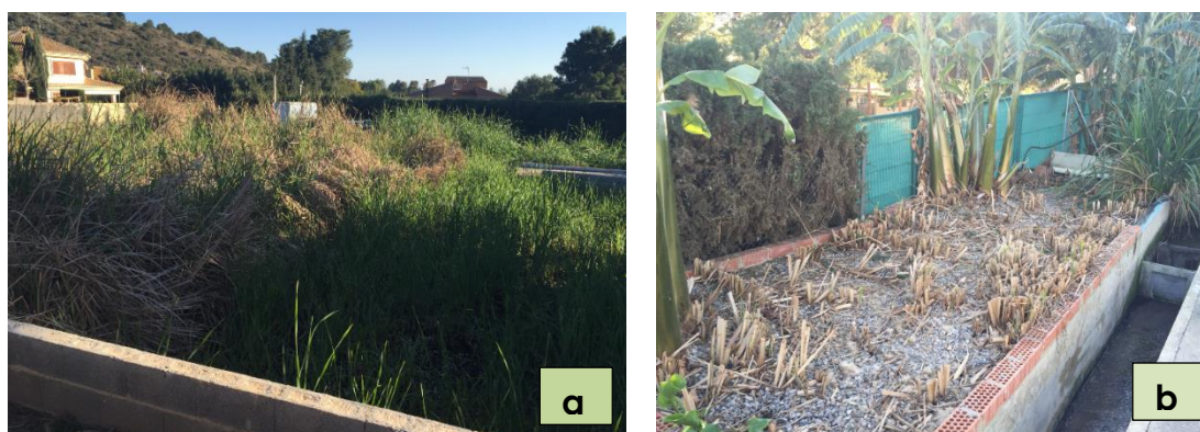
Figura 4.14. Tratamiento terciario en la EDAR Los Monasterios, mediante humedales artificiales: a) flujo superficial y b) flujo subsuperficial
