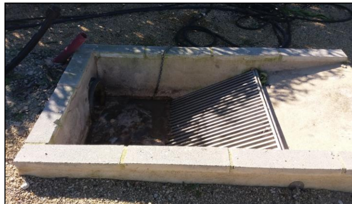
Figura 4.3. Canal de desbaste en la EDAR de Carrícola Fecha: 07 de noviembre de 2016.
