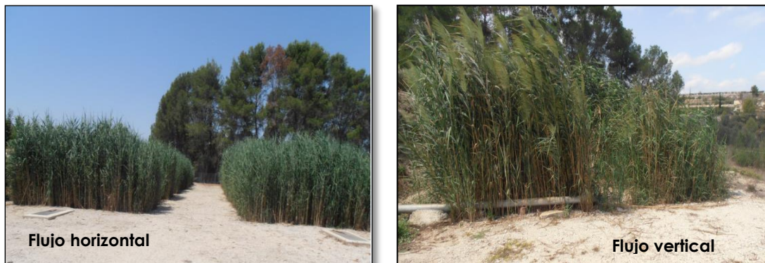
Figura 4.5. Humedales artificiales subsuperficiales de flujo horizontal y vertical en la EDAR de Carrícola. Fecha: 27 de julio de 2016
