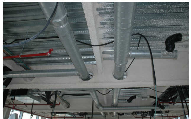
Figura 54. Paso de instalaciones a través de los alveolos.
