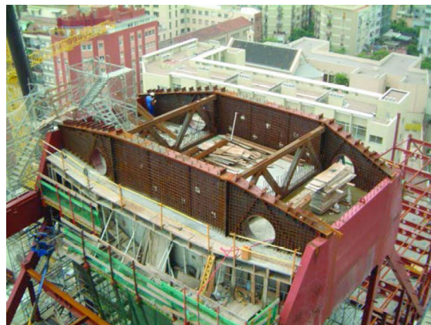
Figura 71. Viga cajón de suspensión. Encofrado losa inferior..
