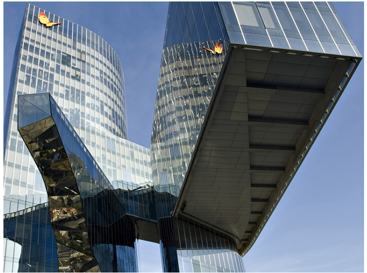
Figura 34. Edificio Gas Natural. Vista bajo el edificio 'Portaaviones'.
