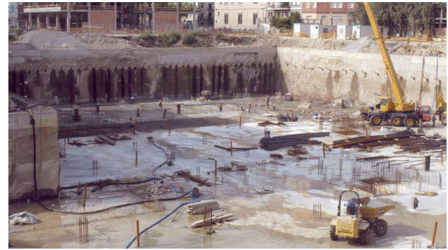
Figura 60. Losa de cimentación de los sótanos.
