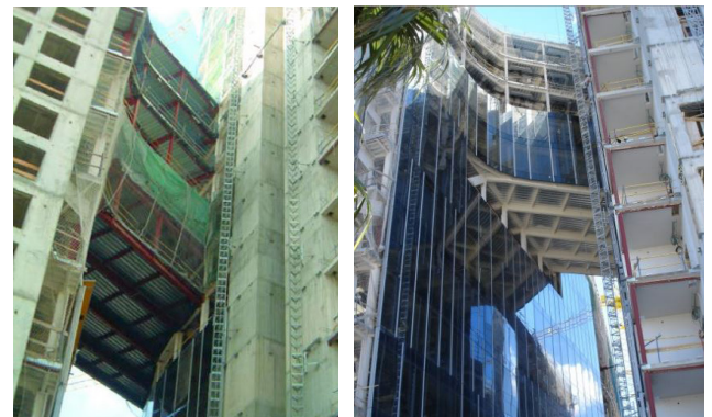
Figuras 74a y 74b. Proceso de construcción del edificio 'Puente'.
