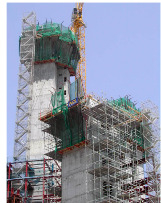
Figura 65. Encofrado autotrepante de núcleos N1 y N3.
