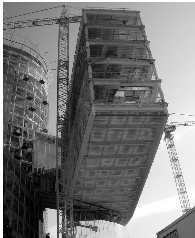
Figura 72. Ejecución de la estructura del 'Portaaviones'.
