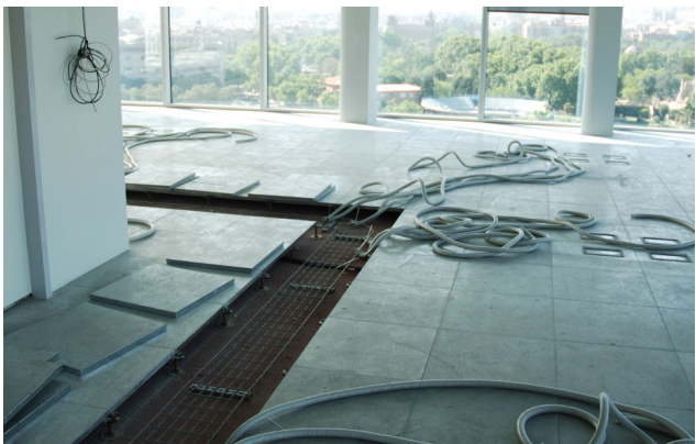
Figura 50. Suelo técnico registrable.
