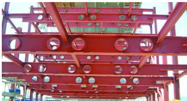
Figura 56. Vigas principales del edificio 'Portaaviones'.
