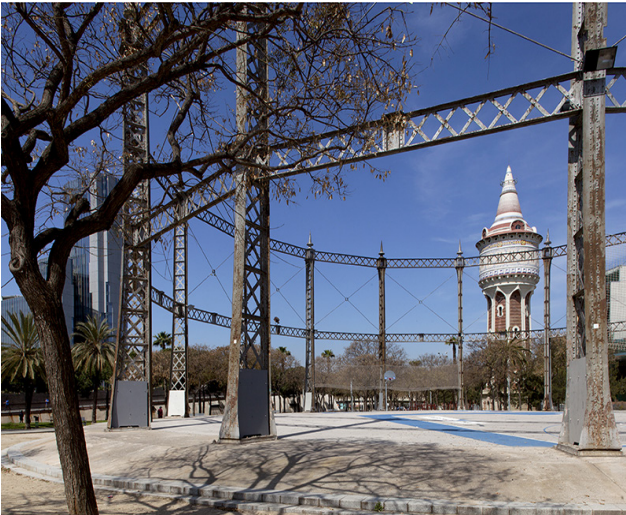
Figura 22. Gaseoducto en la Barceloneta. Actualidad.
