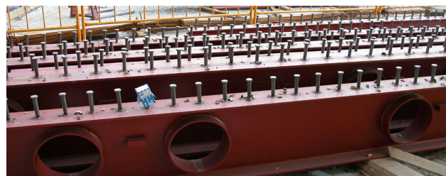
Figura 59. Pernos de conexión en alma superior de vigas.
