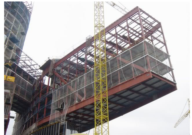
Figura 67. Ejecución de la estructura del 'Portaaviones'.
