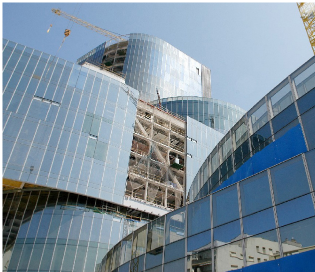
Figura 138. Montaje del muro cortina en el 'Portaaviones'.
