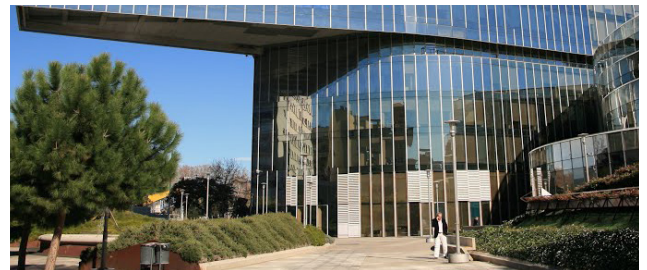
Figura 39. Edificio 'Pétalo', bajo 'Portaaviones'.
