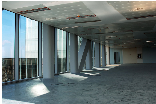
Figura 51. Falsos techos aluminio y forro de pilares y diagonales.
