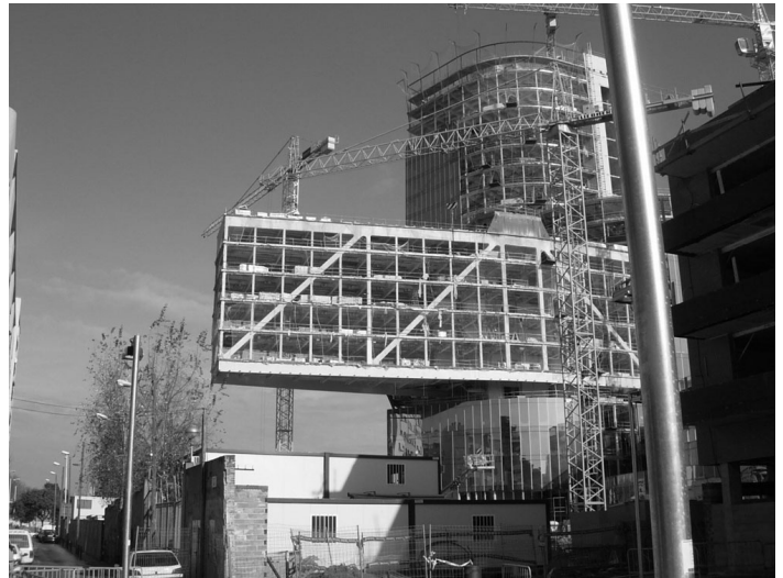
Figura 55. Ejecución de la estructura.
