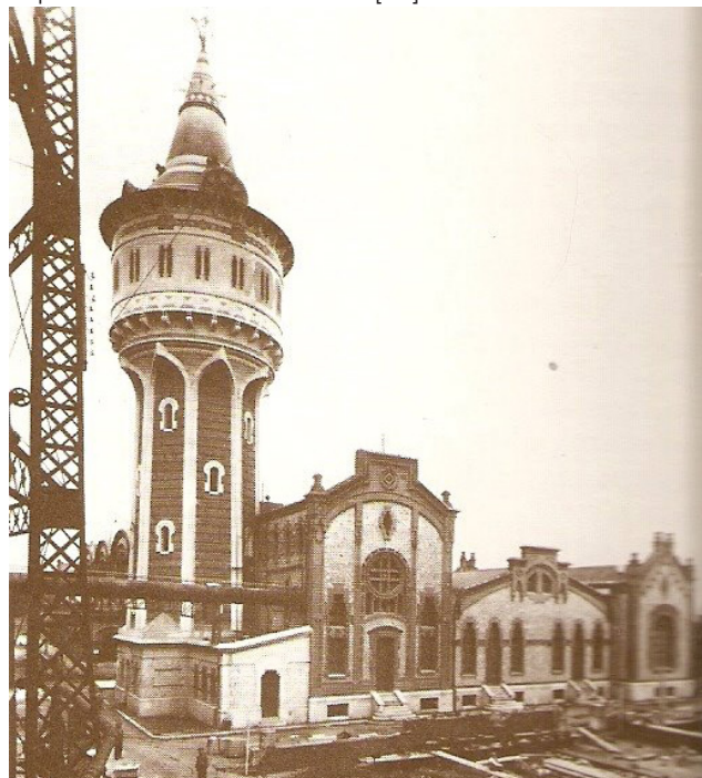
Figura 19. Torre de las Aguas_La Barceloneta
