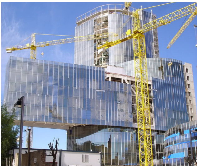
Figura 49. Montaje del muro cortina en 'Portaaviones' y 'Torre'.
