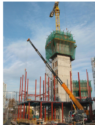
Figura 64. Encofrado autotrepante del núcleo N1.
