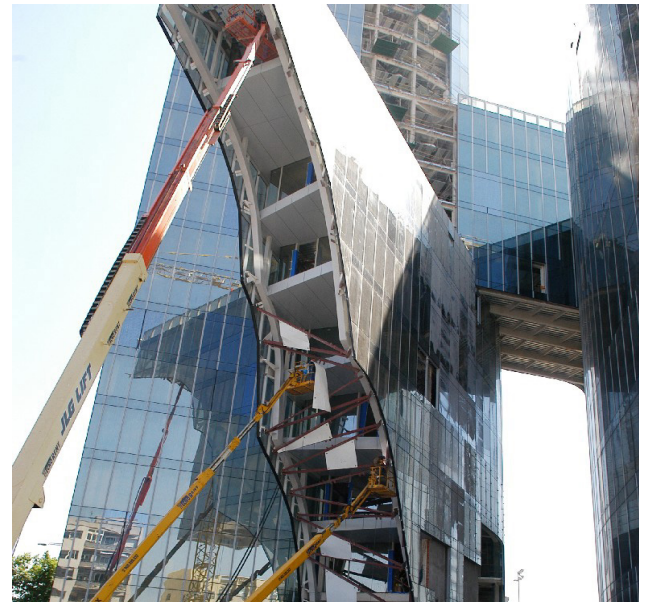
Figura 48. Montaje del muro cortina en edificio 'Capitel'.
