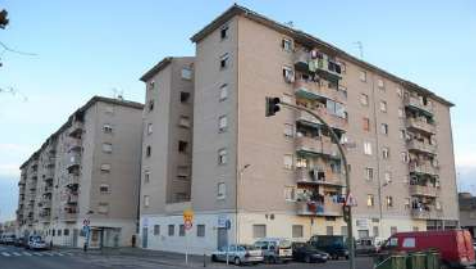
Fig 10. Imagen de los edificios de viviendas de alquiler social propiedad de la Generalitat Valenciana del Grupo San Lorenzo, en Castellón. ELDIARIOCV CASTELLÓN, eldiario.es.
