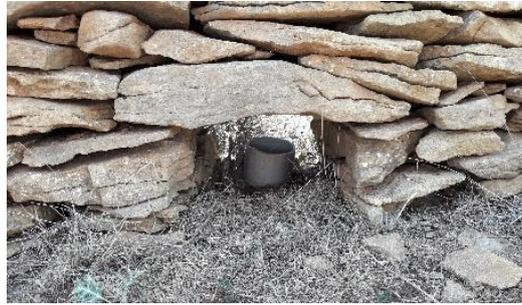
Paso construido para conejos y roedores en el muro. Ilustración 60. P.MLeón. 2017.
