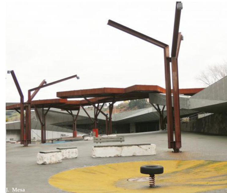
J. Mesa Plaza Pormetxeta - Barakaldo /MTM + Xpiral Configuración íntegra del espacios público con el elemento estructural
