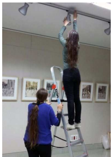
Fig. 23: Colocación de los cáncamos
