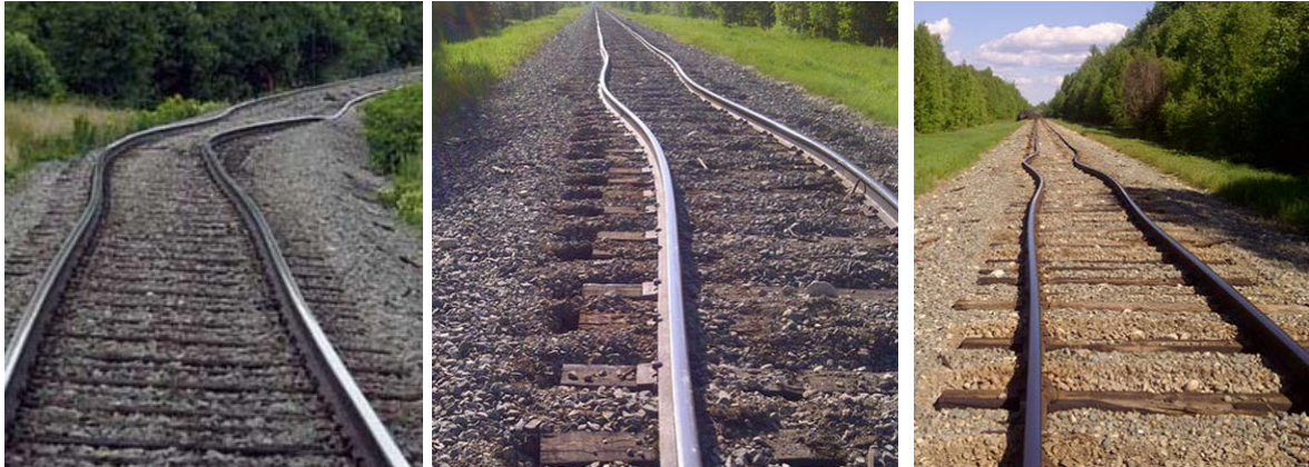
Figura 2.9: Imágenes de pandeo de vía. Fuente: Transportation Safety Board of Canada.
