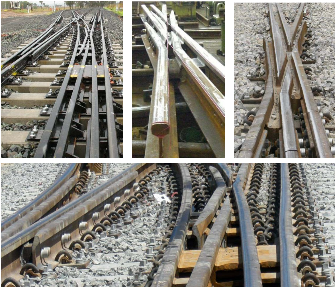
Figura 5.4: Imágenes de desvíos de 3 carriles. Fuente: Vossloh Cogifer Australia.
