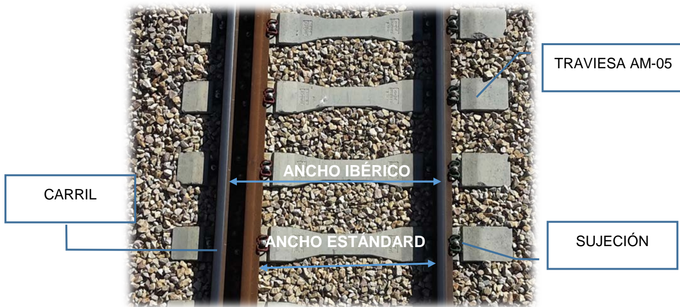
Figura 5.2: Elementos de una vía de doble ancho. Fuente: Elaboración propia.
