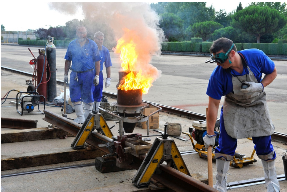
Figura 2.16: Soldadura aluminotérmica de carriles. Fuente: Metro Madrid.
