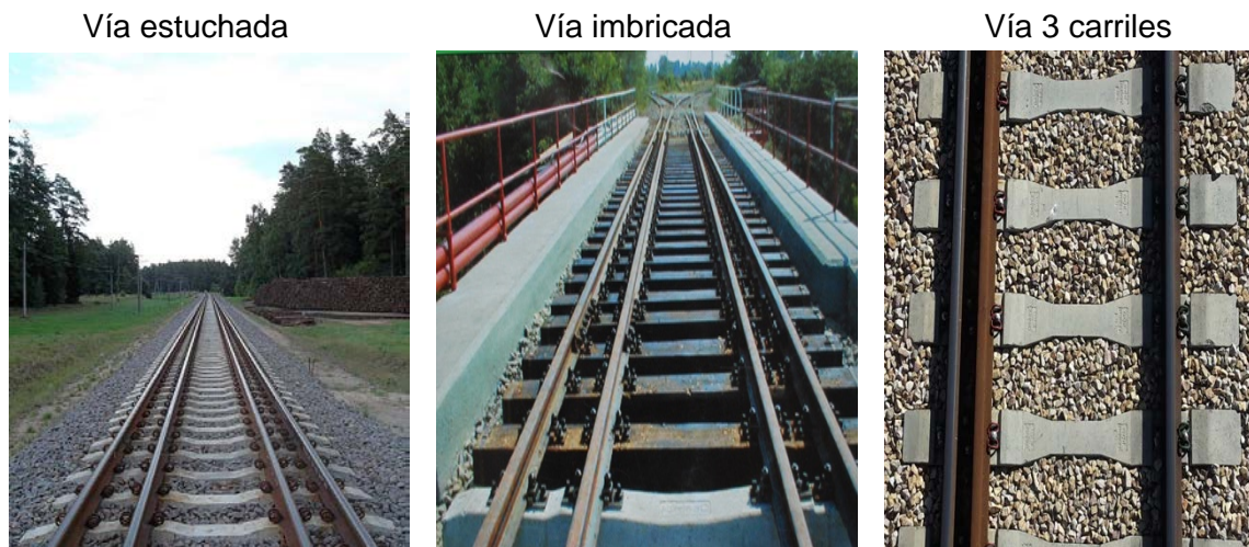
Figura 5.1: Imágenes de las diferentes tipologías de vías de doble ancho. Fuente: Elaboración propia a partir de imágenes.
