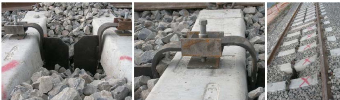
Figura 3.22: Elementos de anclaje en traviesas. Fuente: De Iorio, Pucillo & Alii, (2014).
