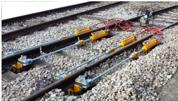
Figura 2.20: Tensor para neutralización de tensiones. Fuente: FCS Railway equipment.
