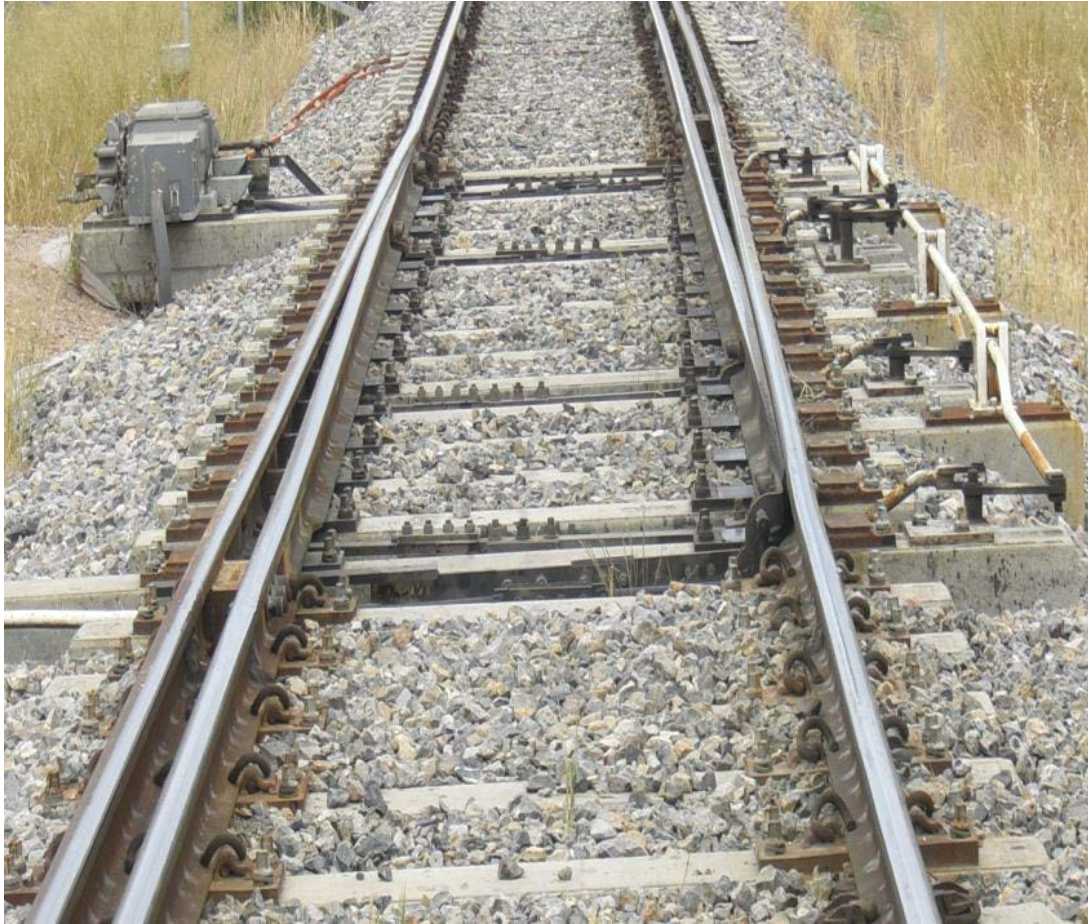
Figura 5.7: Imágen de cambiador de hilo. Fuente: Vossloh Cogifer Australia.
