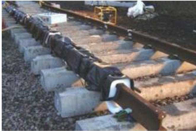
Figura 2.19: Calentamiento de carriles artificial. Fuente: Volker Rail.
