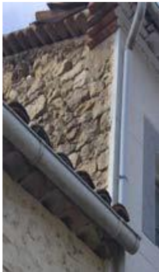
Figura 32. Muro fachada. Fuente: Autor.
