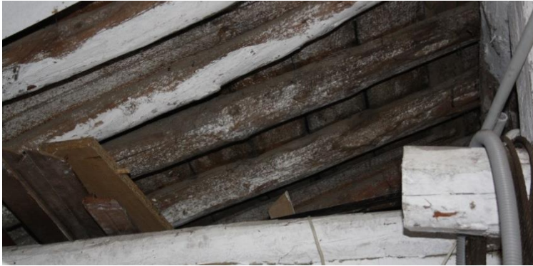
Figura 34. Pares de madera. P.2. Fuente: Autor.
