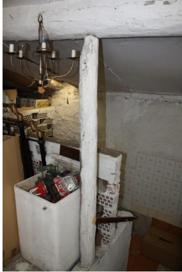
Figura 31. Pilar de madera. P.2. Fuente: Autor.
