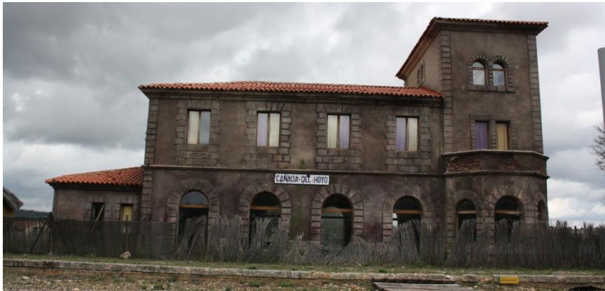
Figura 6. Estación de tren de Cañada del Hoyo. 2017. Fuente: Autor.
