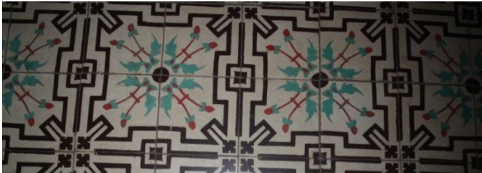
Figura 47. Baldosa hidráulica habitaciones. P.1. Fuente: Autor.
