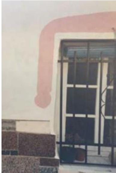
Figura 44. Fachada anterior. Fuente: Autor.
