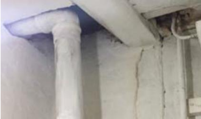
Figura 38. Instalación de saneamiento Fuente: Autor.
