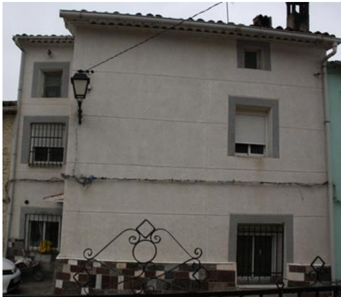
Figura 43. Fachada actual. Fuente: Autor.
