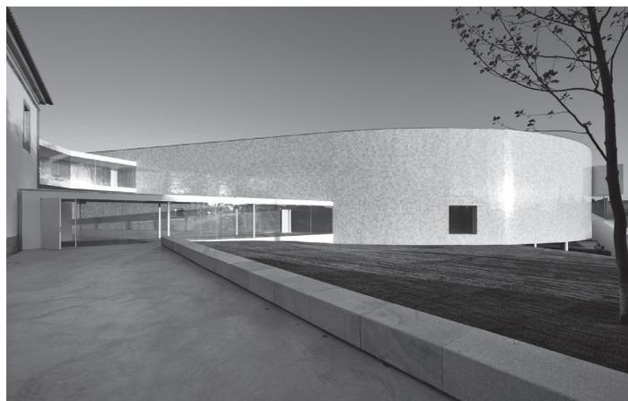
En cambio, el nuevo volumen elige marcar su diferencia con lo preexistente. Levantado parcialmente sobre el terreno abre su lado cóncavo hacia el suroeste mediante una fachada controlada por un sistema de grandes lamas verticales. La fachada opuesta, aquella que sirve de fondo a la correspondencia entre las preexistencias históricas, permanece cerrada por un muro de hormigón forrado por una textura de azulejo manual con 18 variaciones de tono, que recupera una tradición constructiva de la zona.
