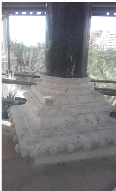
Imagen 48: Esta imagen nos permite apreciar tanto la reintegración volumétrica imitando lo original como la reintegración cromática.
