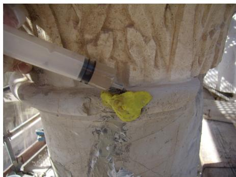
Imagen 33: Inyección de resinas.
