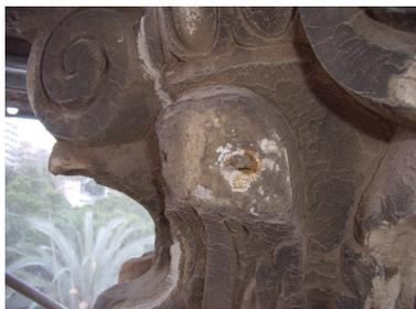
Imagen 23: Intervención anterior donde se colocó un elemento férreo como sujeción del faltante a modo de perno.
