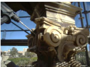
Imagen40: Realización de una microperforación en ángulo de 45°.
