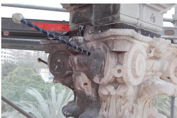
El cosido estructural será realizado mediante pernos de fibra de vidrio, para su adhesión se empleará una resina epoxi con o sin carga tixotrópica; la terminación se efectuará mediante el taponado con mortero de cal para evitar el ataque de los rayos UVA (Imagen 41).
