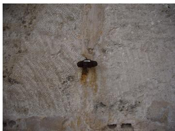
Imagen21: Elemento metálico que ha quedado obsoleto y daña la piedra por su oxidación.
