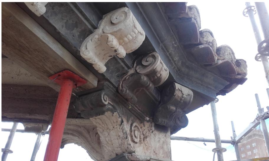
Para las costras negras y suciedad intensa utilizaremos una limpieza mecánico-química que consiste en una limpieza general en seco llamada Micropilling proyectando sobre la superficie macropartículas abrasivas de granulado anguloso que golpean las costras y la disuelven sin afectar al paramento ni a la pátina (Imagen 42).
