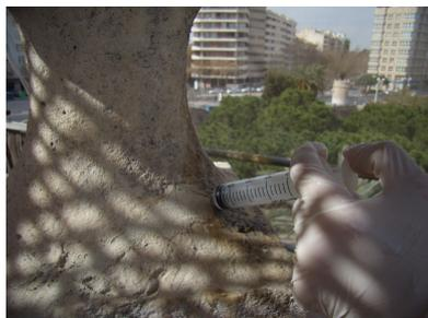
Imagen 30: Inyección de acetato de polivinilo al 10% en las fisuras.
