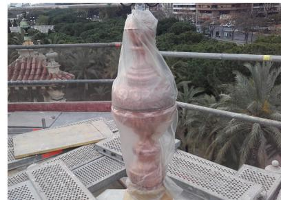
Imagen 37: Eliminación de las partículas disgregadas que acumulan la suciedad.
