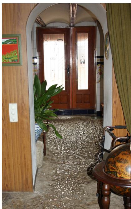
Fig. 31 y 32: Arco de medio punto construido sobre parte el empedrado.
