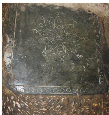
Fig. 15: Piso de cemento Portland® decorado.
