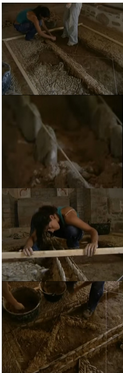
Fig. 10, 11, 12, 13: Realización de un empedrado de cantos rodados.
