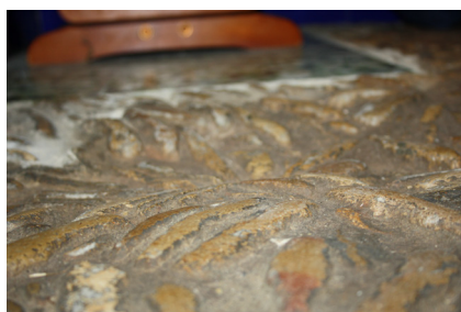
Fig. 34: Zona del pavimento hundida.
