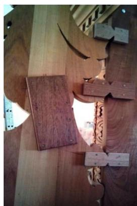
**Imagen 133.** Sistema de ensamblaje
