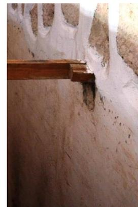
**Imagen 113.** Sistema de anclaje al muro mediante mechinales
