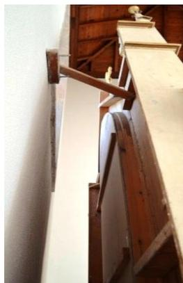
**Imagen 112.** Sistema de anclaje al muro
