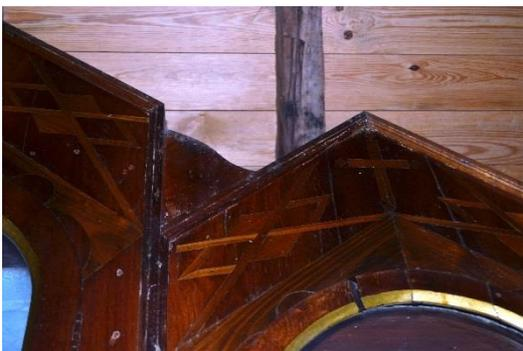
*Imagen 68. Descohesión entre las partes*
