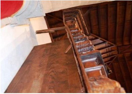
*Imagen 44. Tirantes de sujeción al muro*
