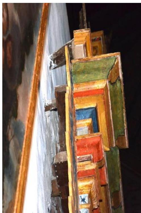
*Imagen 76. Sujeción al muro*
