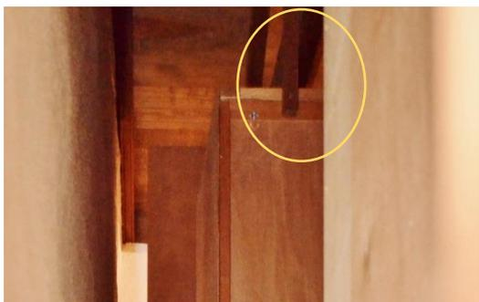
**Imagen 147.** Sistema de sujeción al techo
