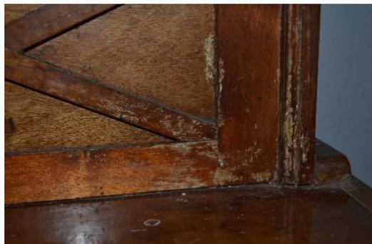
*Imagen 67. Presencia de humedad y estado de conservación de la madera*
