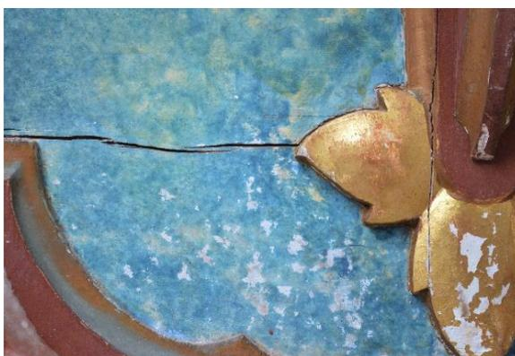
*Imagen 7. Detalle de las grietas de la madera*
