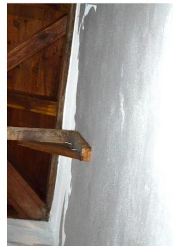
Imagen 130. Tirantes de sujeción al muro
