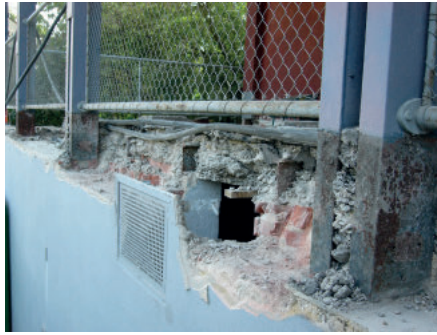
14. Pilar de acero y enlucido 14. Steel pillar and rendering
