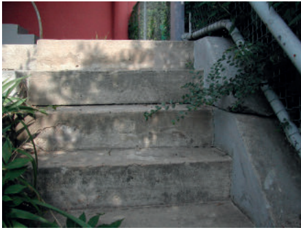
13. Escalera de salida 13. Stairs to exit
