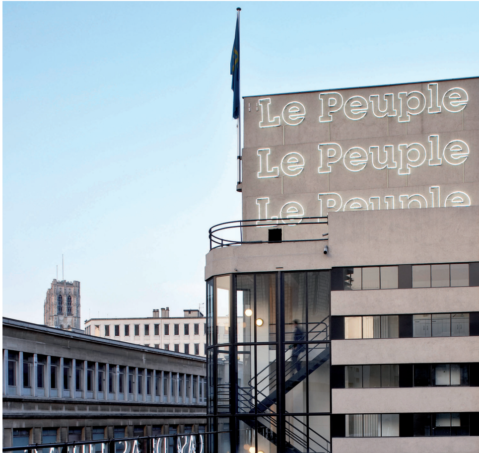
1. La torre tras la intervención con la catedral al fondo (foto: Marcos Morilla)
