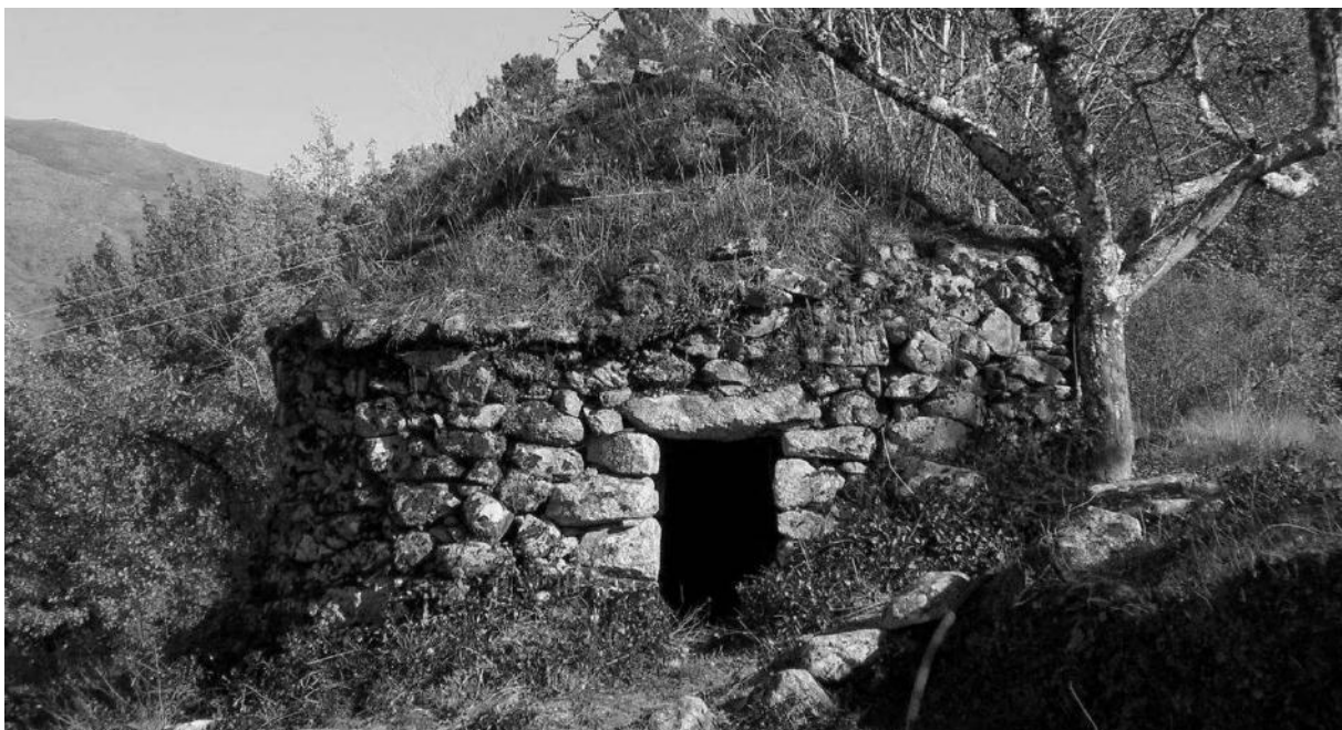
Figura 12. Cubiertas vegetales, denominados zahurdones, en la sierra de Cachaza (Extremadura).
