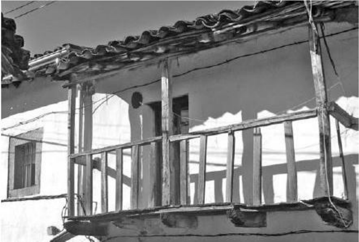
Figura 8. Solana apoyada en canes de madera (Navamediana, Ávila). Fuente: Arquitectura vernácula de la Sierra de Gredos y el valle del Alto Tormes, pág. 75. (Autor: Gil Crespo, Ignacio Javier).
