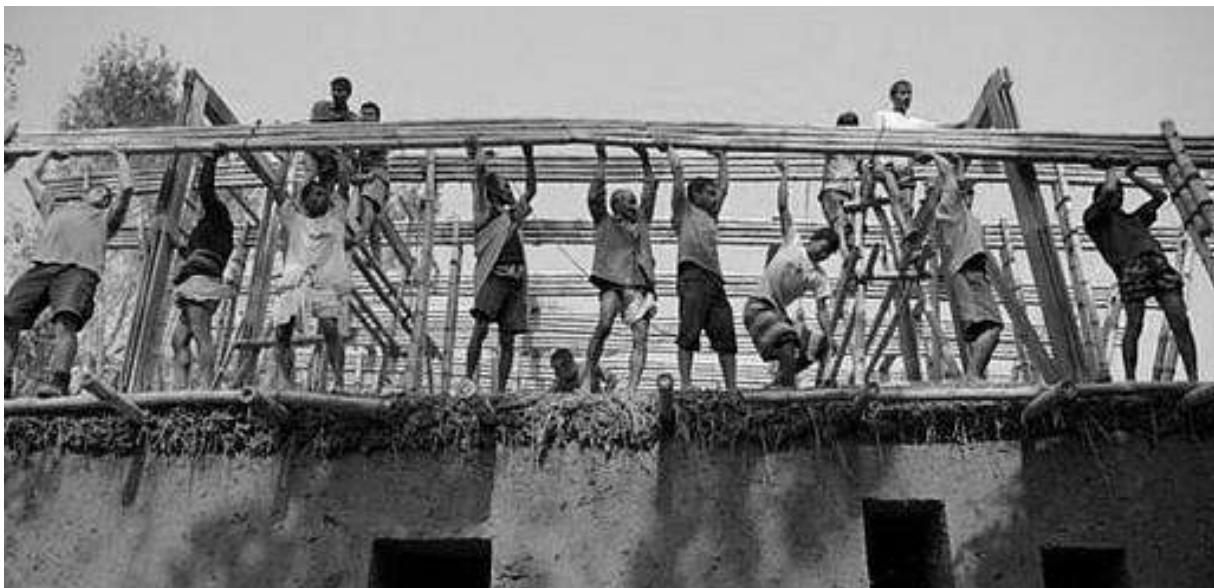
Figura 40. Colocación de viga de cubierta por mano de obra local no formada recibiendo instrucciones orales (Bangladesh).
