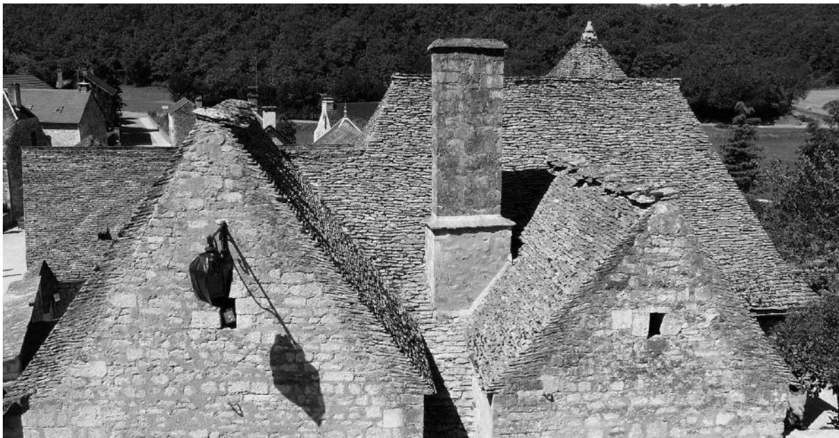
Figura 5. Cubierta inclina como respuesta al clima y a los materiales autóctonos (Saint-Amand-de-Coly, Francia).
