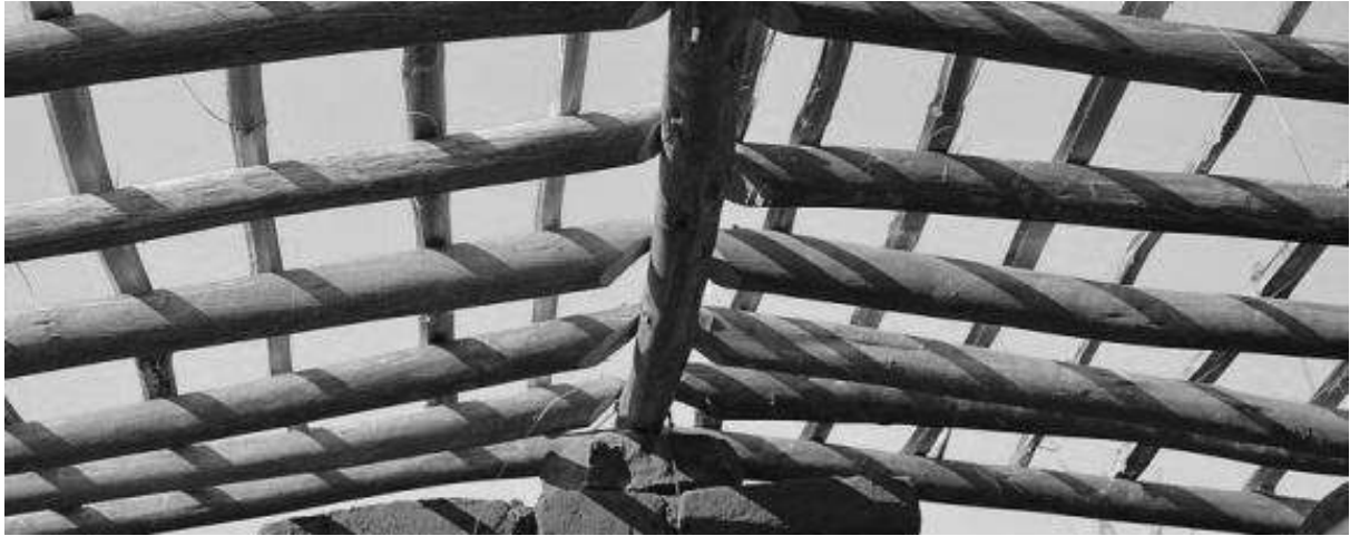
Figura 11. Estructuras de madera en la cubierta vernácula. (Nithete, Malawi).
