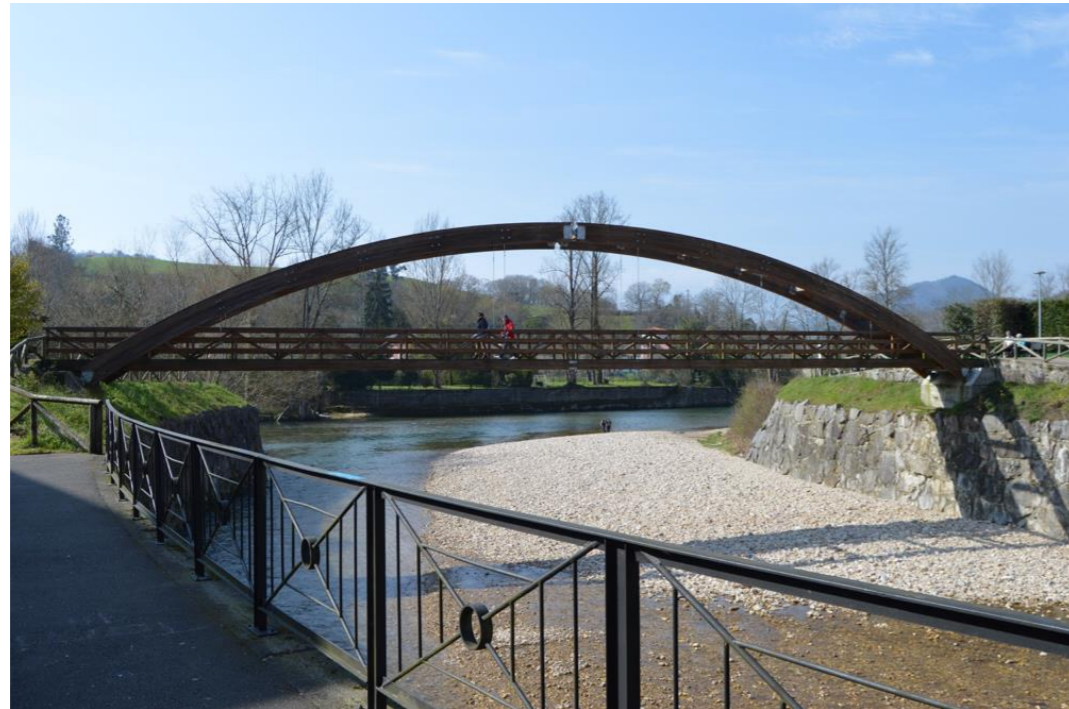
Ilustración 13: Puente peatonal en Asturias
