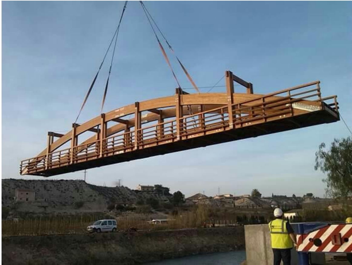
Ilustración 51: Ejemplo montaje pasarela, colocación de estructura principal
