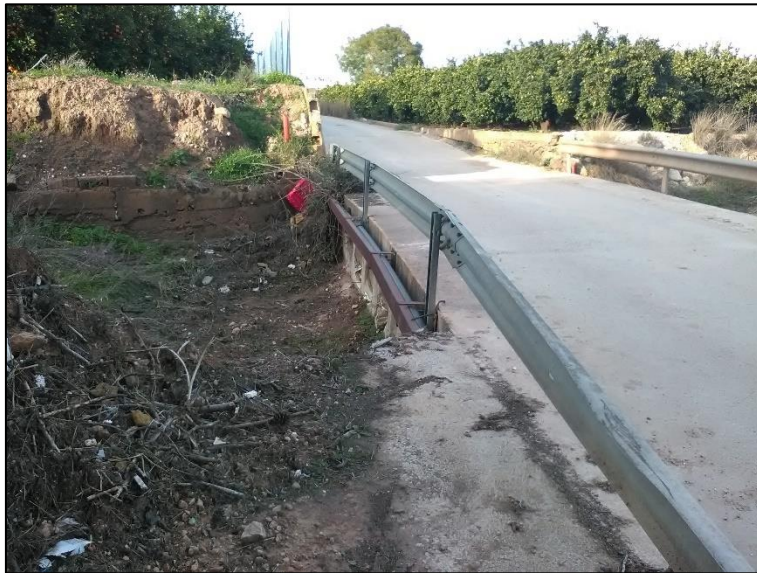
Fotografía nº 7: Vista de la conducción de riego anclada a la actual obra de drenaje.
