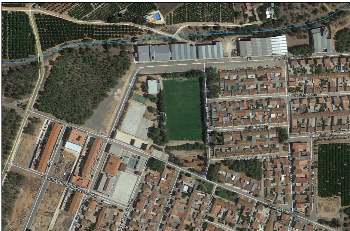
Fotografía nº 6: Vista cauce del Bco. de Pedros, parcela y viales inundados en episodios de lluvia intensa.
