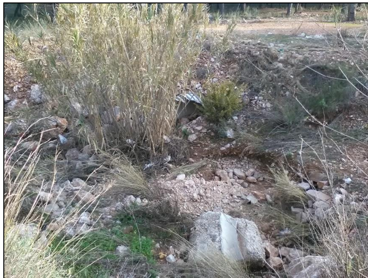
Fotografía nº 5: Vista de la conducción tipo Ribloc en el punto de vertido al cauce del Bco. de Pedros.
