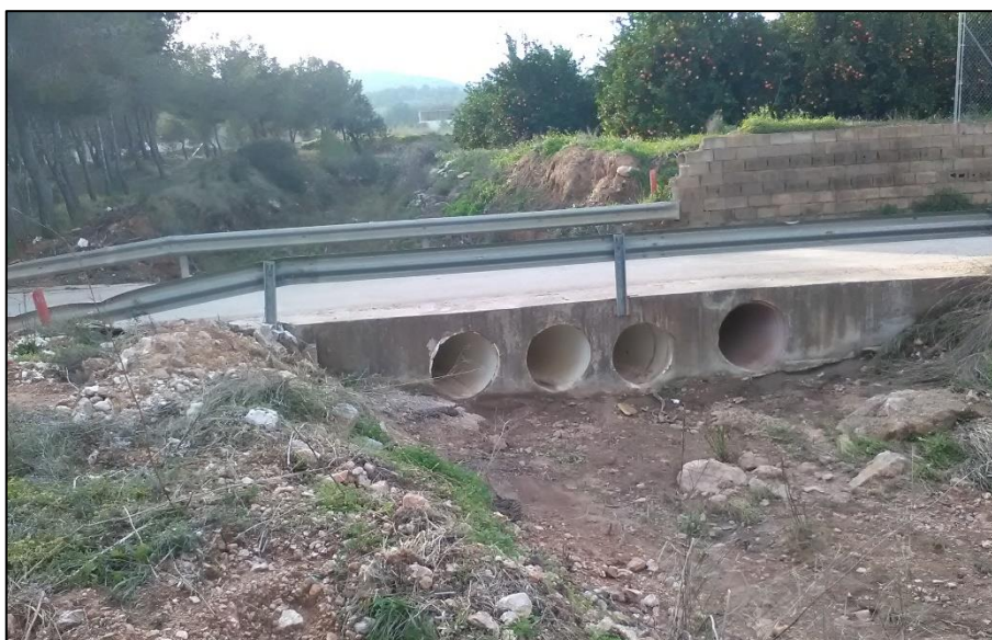
Fotografía nº 1: Obra de drenaje del Bco. de Pedros en el cruce con camino la Lloma de la Llanterna.
