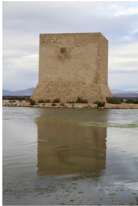
Fig. 7- Torre de Tamarit (Santiago Varela, 2014)
