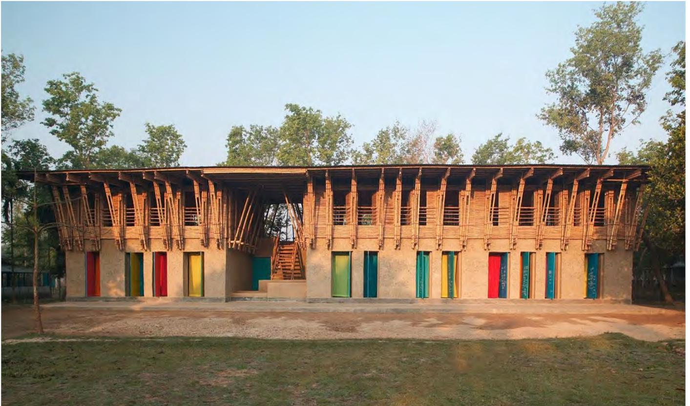
El edificio se apoya sobre una cimentación de ladrillo de medio metro de profundidad que, junto con una barrera de vapor de polietileno, son novedades introducidas por Anna Heringer para solucionar los problemas existentes de humedad.
