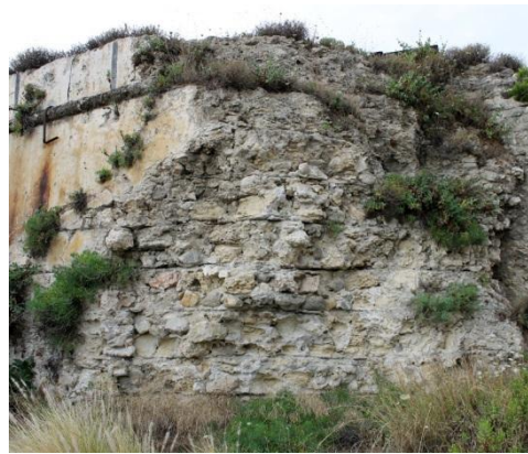
Fig. 4 - Dettaglio della sezione muraria della cortina-fronte 3.
