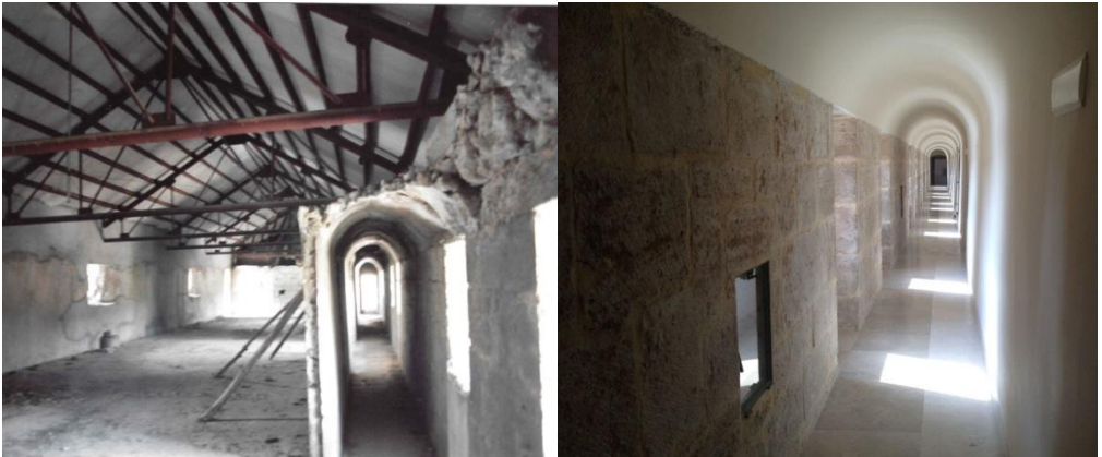
Fig. 12-Corredor de planta segunda que da acceso a las ventanas y saeteras de las fachadas, antes y después de la intervención.
