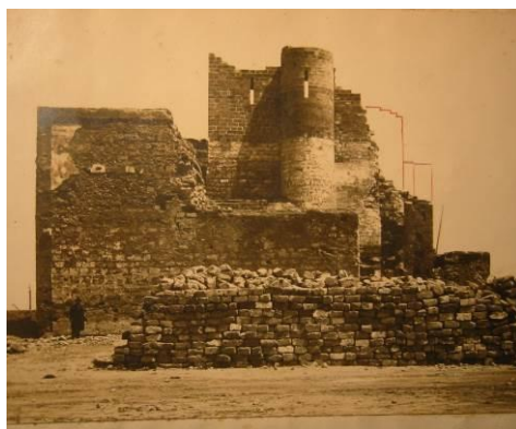
Fig. 9- Veduta ovest dei resti del Forte con una torre circolare, rinvenuta durante le demolizioni. Le linee a destra, tratteggiate da Valenti, indicano in didascalia «la parte crollata da rialzare col materiale caduto» (Fondo Valenti).
