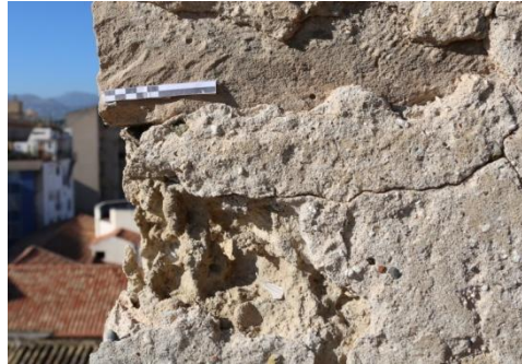
Fig. 6 - Grave alveolizzazione di uno spigolo.
