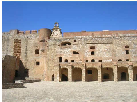
Fig. 6- Vista del gran patio después de la recuperación
