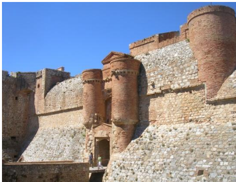
Fig. 3- Vista de la entrada de la fortaleza
