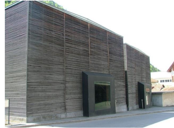
Imagen 5. Edificio Chur, edificio para albergar restos arqueológicos romanos, Chur, Cantón de los Girones, Suiza. 1986.
