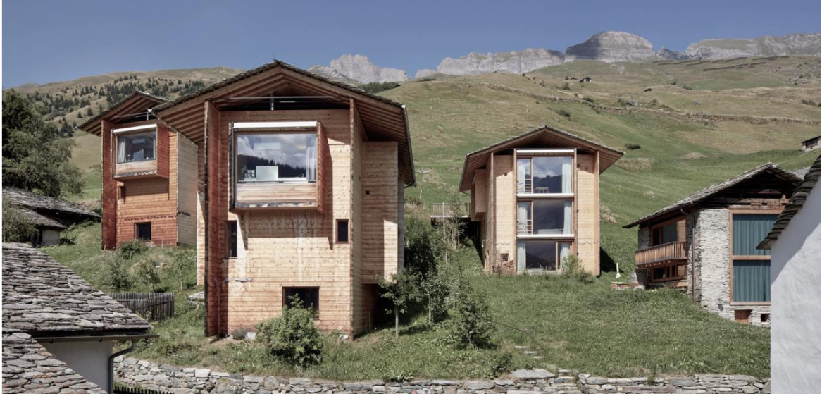
Imagen 69. Vista exterior del conjunto.
