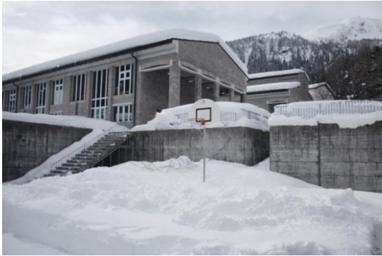
Imagen 1. Escuela elemental Churwalden, Churwalden, Cantón de los Girones, Suiza. 1983.
