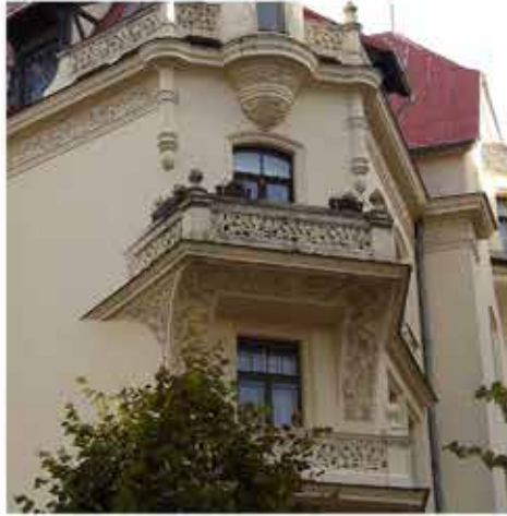
Detalle 25. Barandilla de obra con ornamentación floral.
