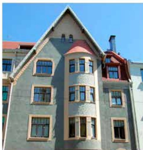
Detalle 33. Cuerpo transversal con cubierta a dos aguas.
