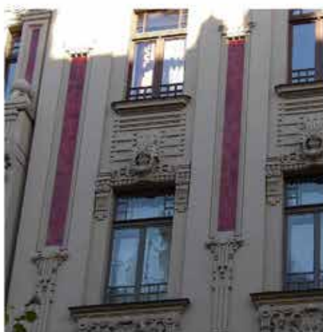
Detalle 20 Ornamentación y detalle de azulejos rojos.
