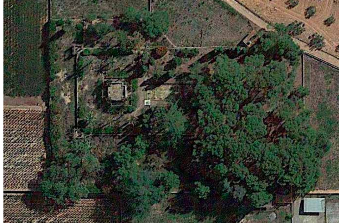
> FIG.135 Ortofotografía emplazamiento
